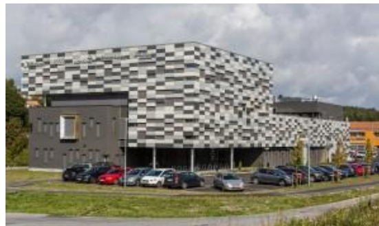
FIGUR 17: SIGNALBYGGET WILBERG ATRIUM (BREEAM-NOR, U.D.-B).
