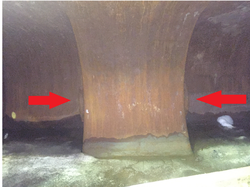
Figur 4.5: Fjerning av lokk og bolter inne i skuff
