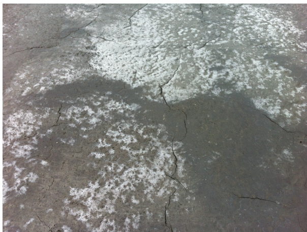
Figur 9.10: Foto av plastiske svinnriss på Fornebu S [Kilde: Karen Hagby]
