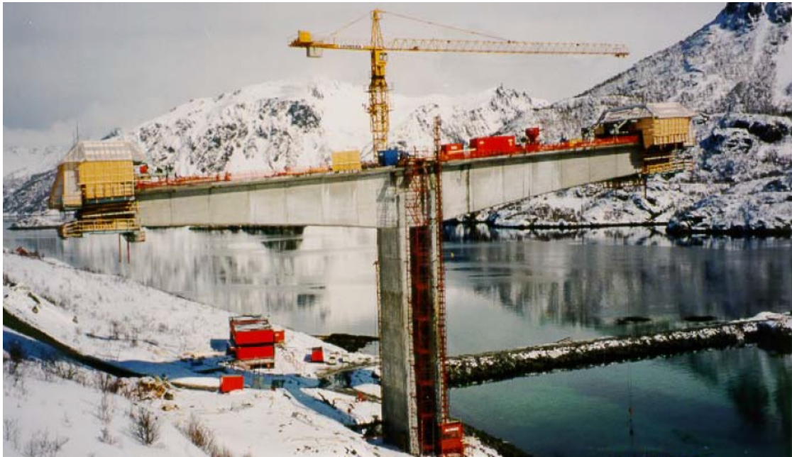
Figur 2.1: Raftsundet bru under bygging
