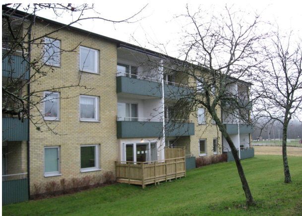
Figur 10: Nye frittstående balkonger skal erstatte de gamle for å unngå kuldebroer og utvide stuearealet. Ytterveggen i inngangspartiene blir også flyttet ut
