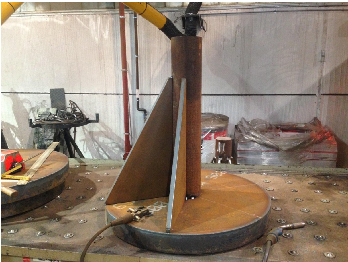
Figur 2.3: Pelskoen punktsveises før den settes inn i sveiseroboten
