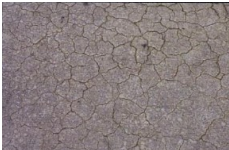
Figur 8.4: Typisk plastisk svinn riss [26]
