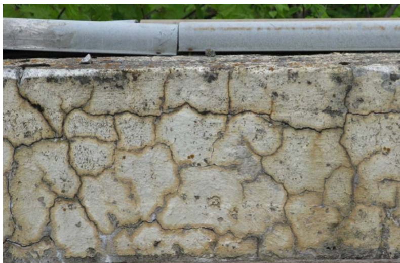
Figur 8.9: Eksempel på riss grunnet alkalireaksjoner i betong [33]
