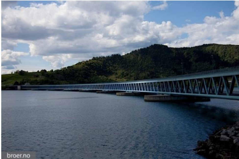
Figur 3-1 Bergsøysundbrua, hentet fra (Bjertnæs, 2012)
