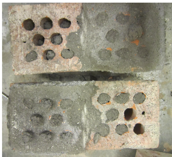
(a) Tverrsplitting av mørtelfuge
