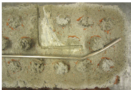
(c) Spor i mørtelfugen hvor binderen har beveget seg
