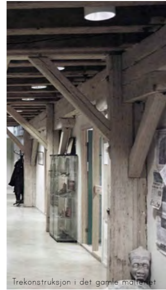
Trekonstruksjon i det gamle møllet
