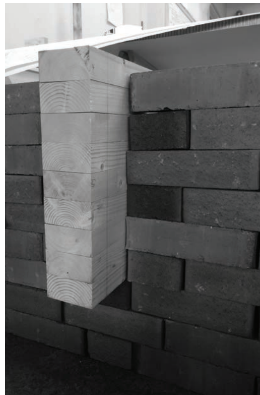
Prosessbilde 1:1 workshop med teglstein Innfesting av limtrebjelke
