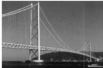
(b) Ferdig bru
