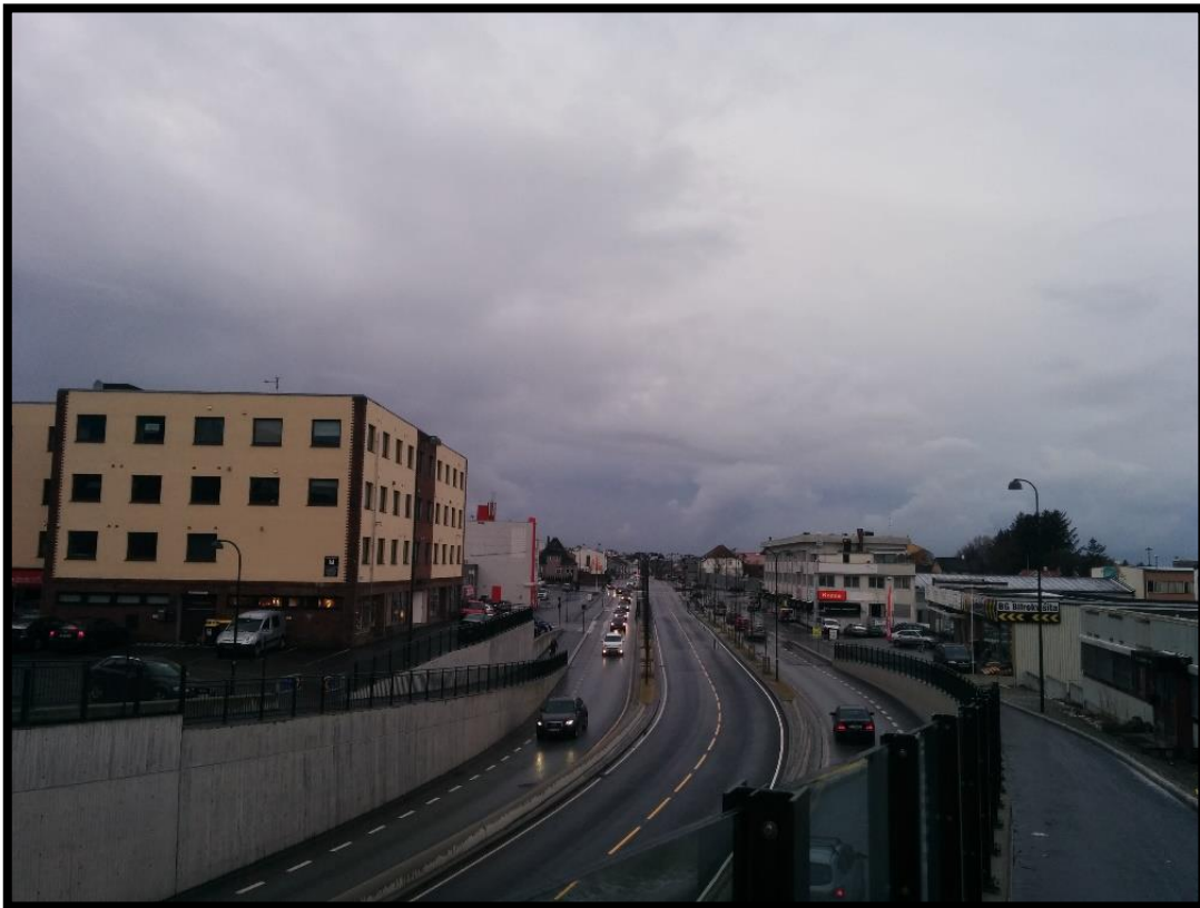
FIGUR 20: Hillevågsveien mot nord fra kulvert. (Eget foto 2015).
