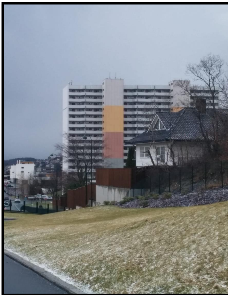
FIGUR 8: Høyblokk Gulaksveien 2 (Eget foto 2015).
