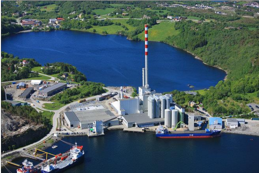
Figur 8: Skretting fabrikk har investert 1 mrd. kr. siden 2007. (Foto: ilaks.no)
