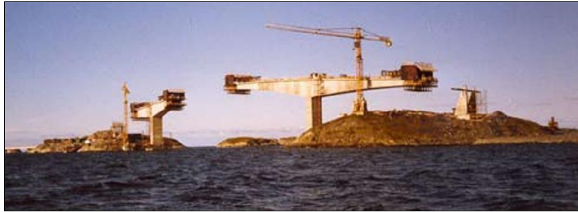
Figur 11: Bygging av bro på Atlanterhavsveien (Statens vegvesen)
