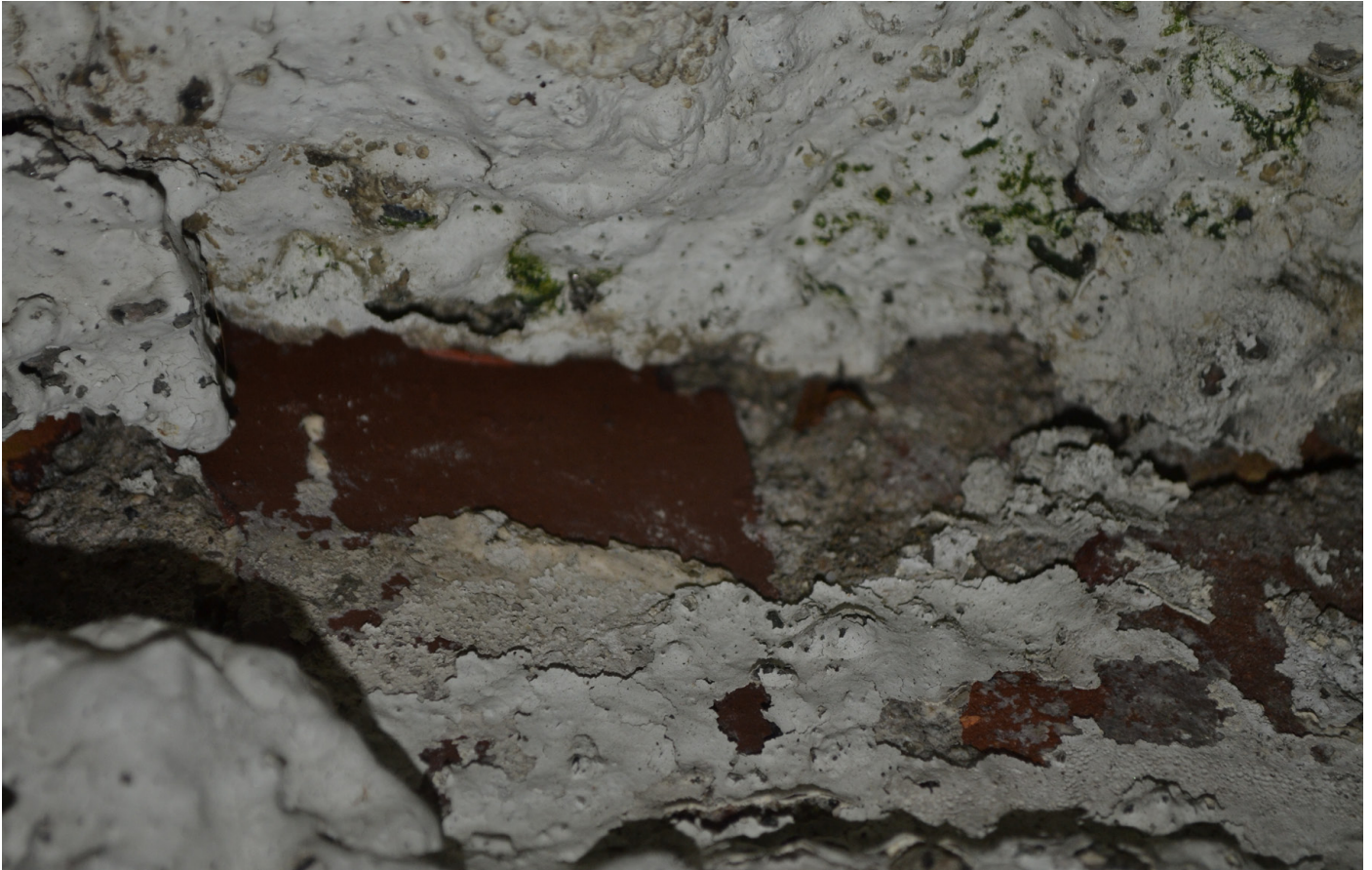
Her er litt av den ytre muren tæret vekk, og da kan man tydelig se at muren er av tegl.
