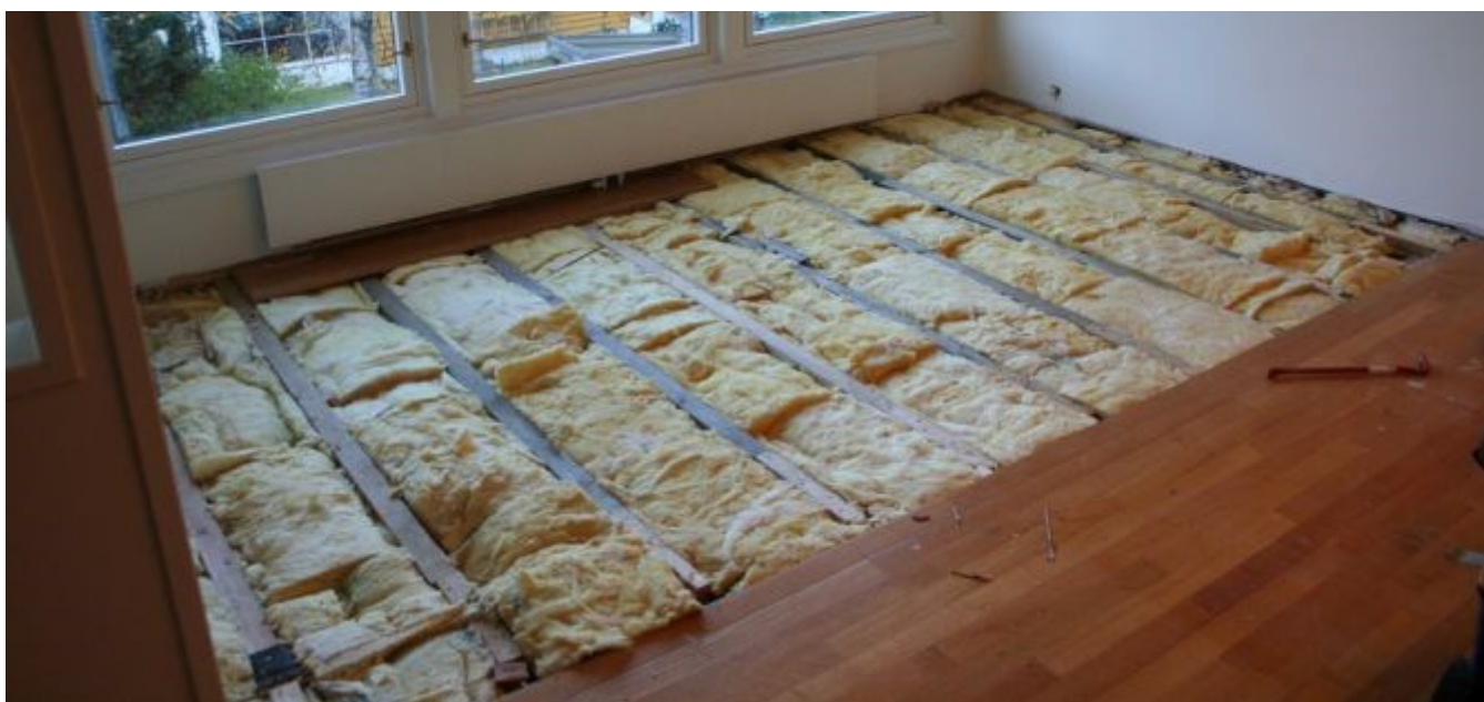
Etterisolering og ny parkett på overside av gulv i kjeller/nederste etasje. Bildelink: http://www.byggebolig.no/trearbeider-konstruksjoner-isolering/bytte-isolasjon-under-gulv-uten-a-ta-opp-gulvet/
