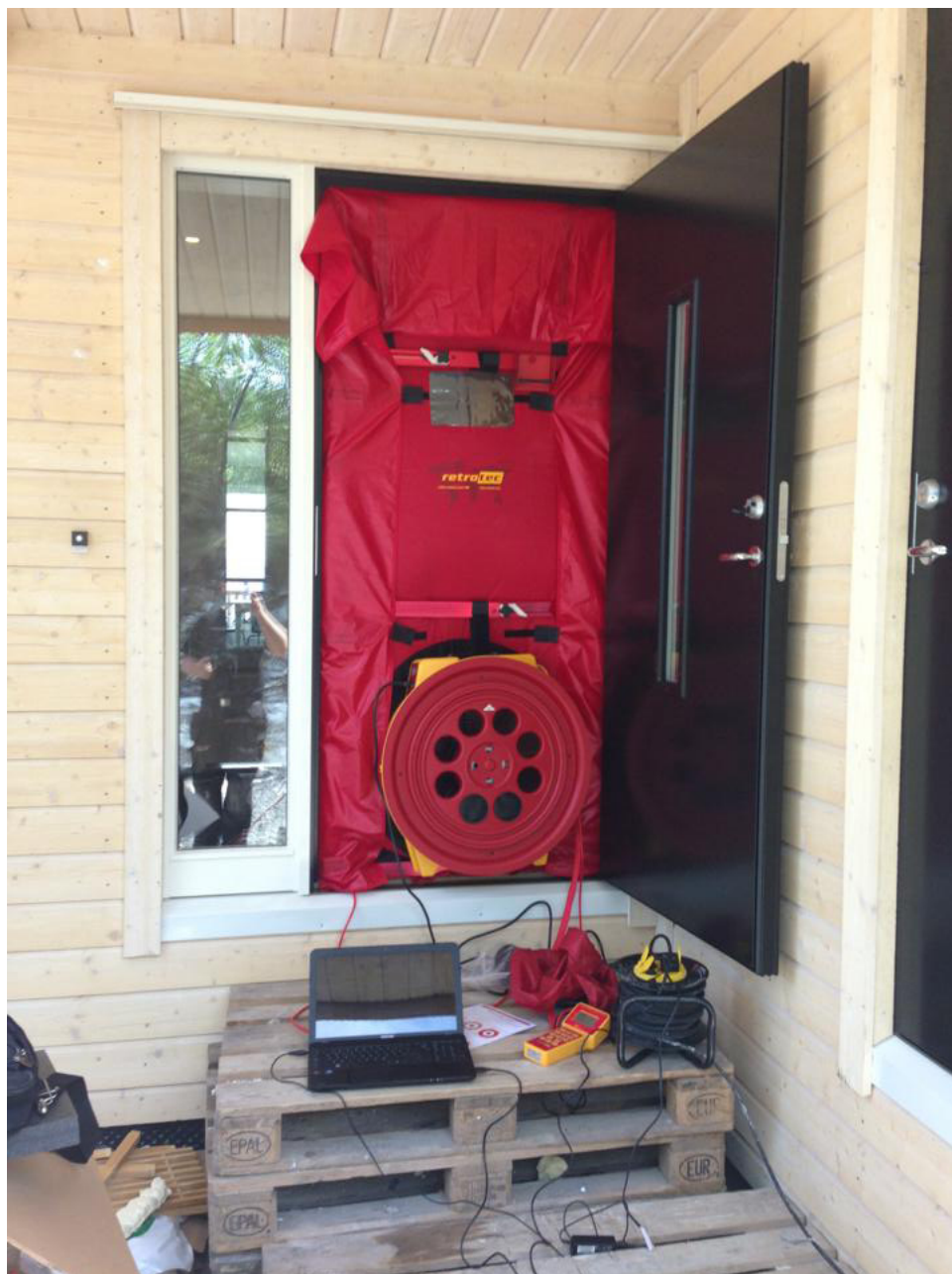
Trykktest av bygning; med vifte i døren for å skape undertrykk i huset. Bildelink: http://maarstigbygg.no/tjenester/trykktestingtermofotografering/
