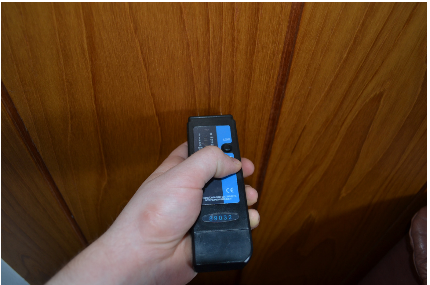
Fuktmåler i bruk.
