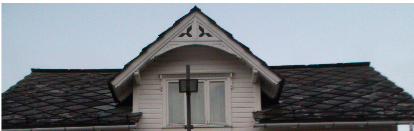
Legg merke til det lille gjerdet som er plassert over takrennen på takets sørside.
