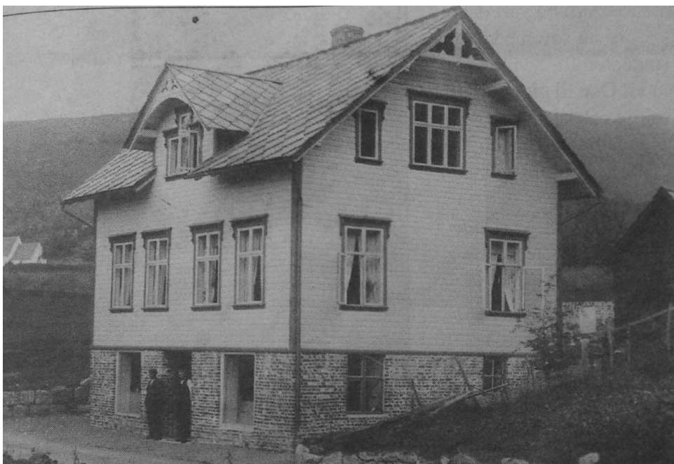
I dette gamle bildet kan vi se at ytterdøren på Gamleposten opprinnelig er sentrert.
