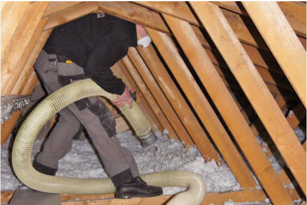
Etterisolering av gulv på loftet. Bildelink: http://www.viivilla.no/energi/isolasjon/etterisolere-loftet/
