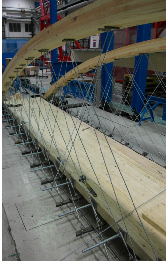
(a) Montering av stag.
