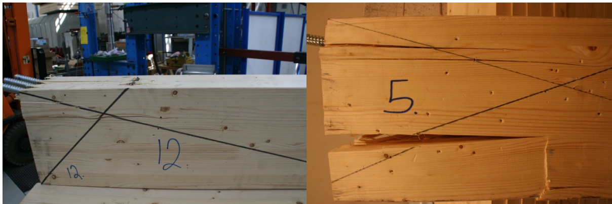
FIGUR 36 VISER FORSKJELLER I SKJÆRSPREKK
