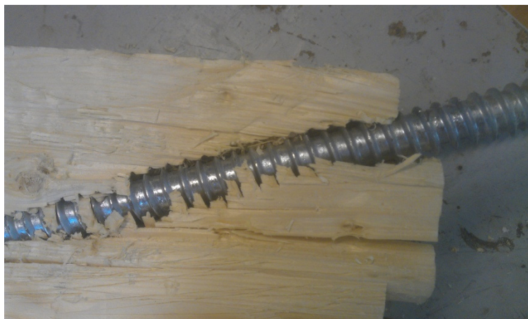
FIGUR 21 UTRIVNING AV MATERIALE
