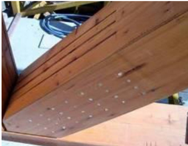
FIGUR 6 DYBELFORBINDELSE
