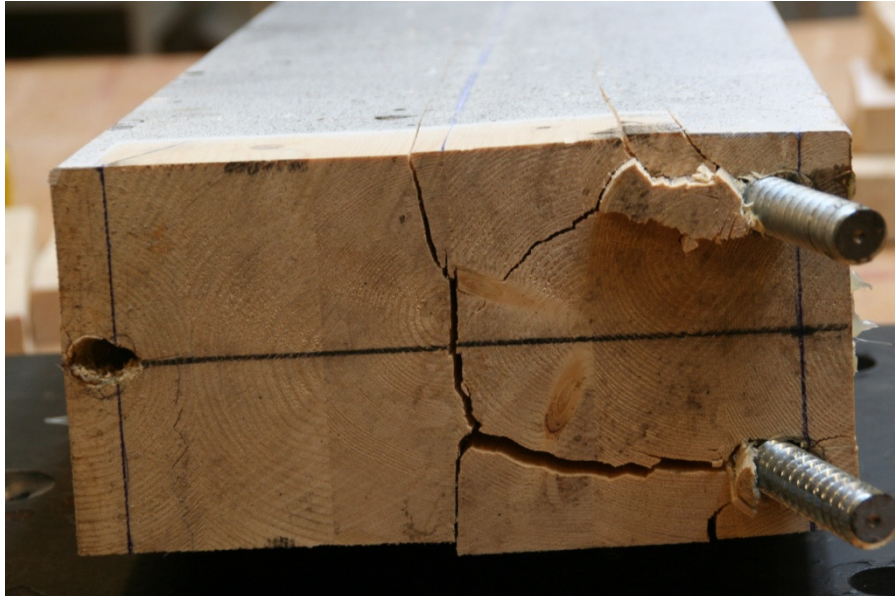
FIGUR 20 OPPSPREKNING ETTER TESTING
