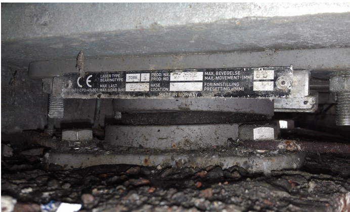
Figur 7.3: Bilde av det ene opplageret på østsiden av broen
