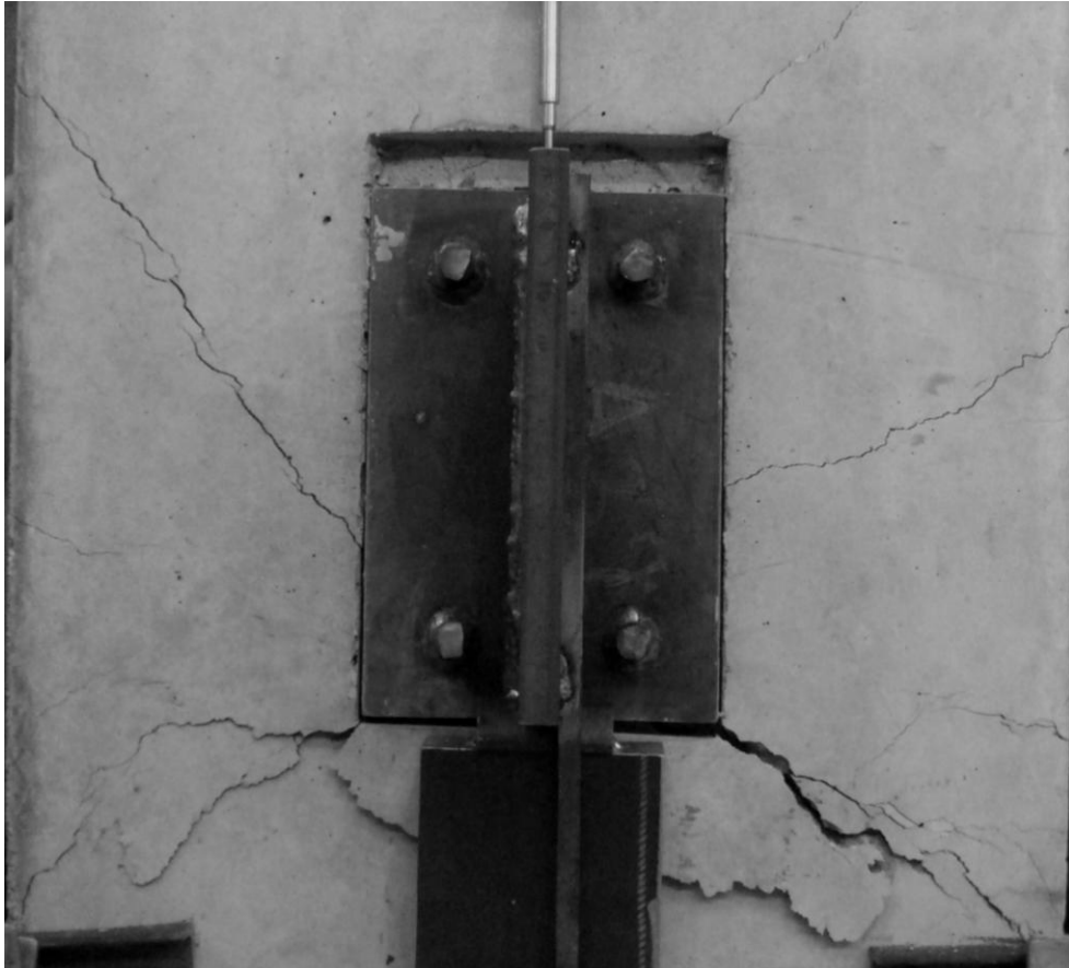
Figur 12.5: Bruddform på overflate av betongprøvestykket A3.2.
