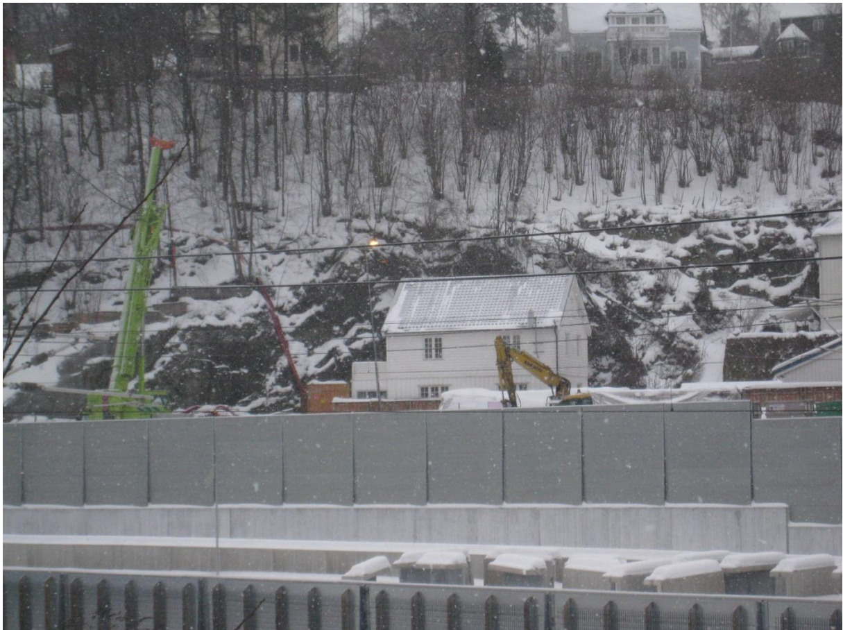
Figur 3-7. Anleggsarbeid, motsatt side av jernbanespor
