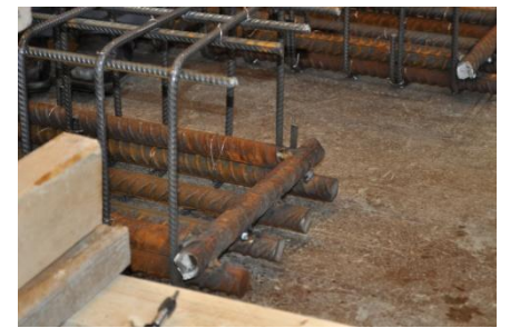
Figur 26: Tverrstang er sveist på armeringen
