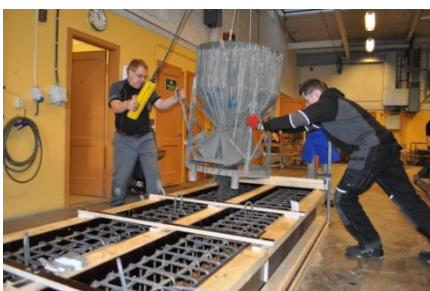
Figur 34: Betongen blir utstøpt med tobb
