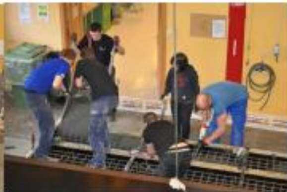
Figur 8: Bearbeiding av betongen Foto: Lisa Bakken
