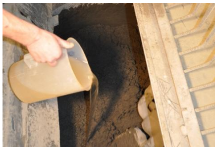
Figur 32: Plastiserende stoff blir tilsatt betongblandingen
