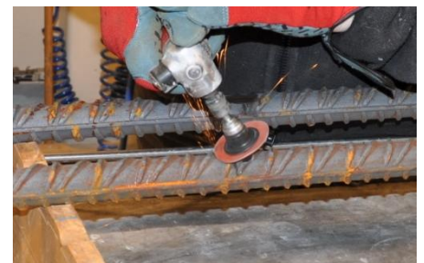
Figur 15: Armeringen blir finslipt
