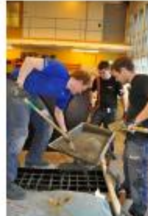
Figur 6: Støp av bjelken Foto: Lisa Bakken
