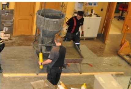
Figur 37: Betongen blir utstøpt med trillebår
