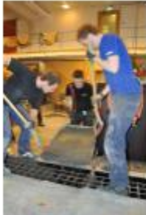
Figur 5: Støp av bjelken Foto: Lisa Bakken
