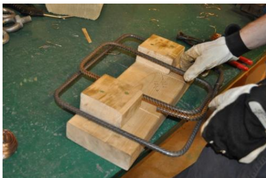
Figur 19: Binding av bøyler til tverrarmering
