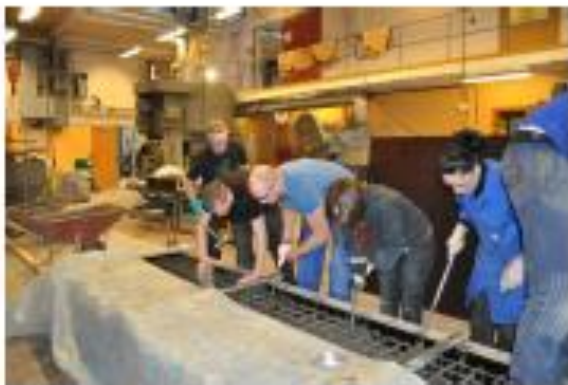
Figur 7: Staking av betongen Foto: Lisa Bakken
