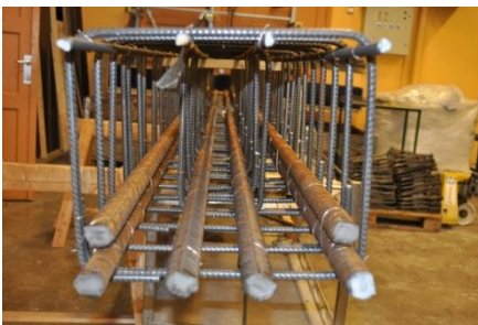
Figur 24: Ferdig armering uten tverrstang
