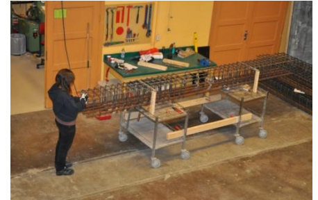
Figur 23: Ferdigstillelse av armering
