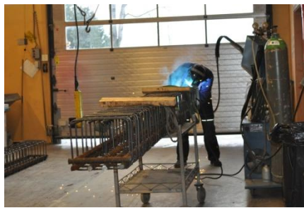
Figur 25: Tverrstang blir sveist på armeringen
