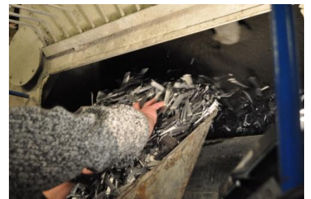
Figur 33: Fiberarmering blir tilsatt betongblandingen
