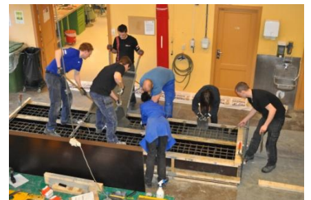
Figur 39: Betong med fiber bearbeides
