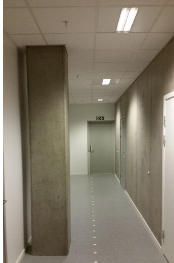
Figur 6-9: Hindringer langs rømningsveien er ikke merket. Bildet er tatt på Thora Storm VGS.
