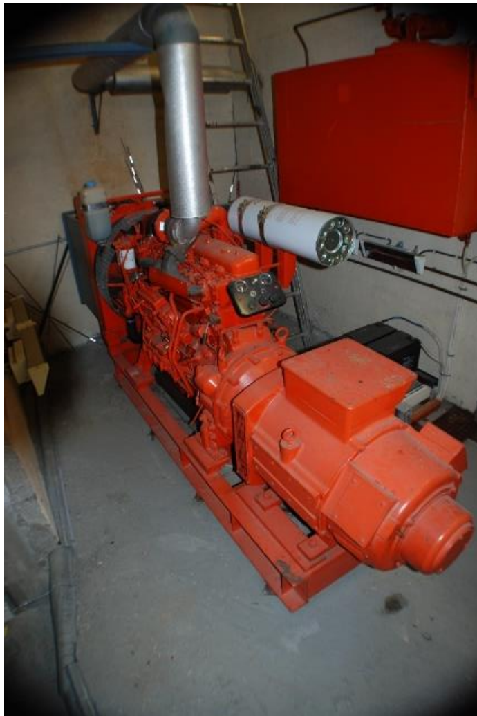
Figur 29: Diesellaggregat ved inngangen til adkomsttunnelen.
