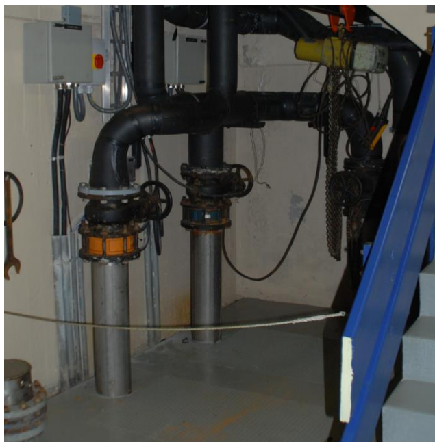
Figur 30: Rørføringer for lenseanlegg ut fra lensekum.
