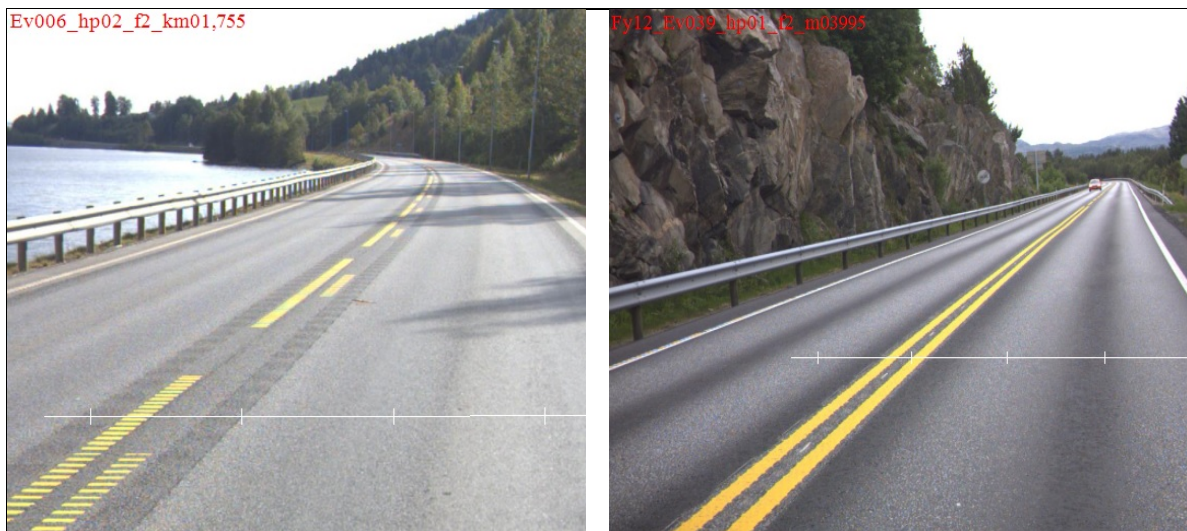
Figur 14 Midtlinje på innsiden av fresesporet på E6 hp 2 m 1755 i Oppland. Figur 15 Midtlinje merket opp nede i fresesporet på E39 hp 1 m 3995 i Hordaland.
