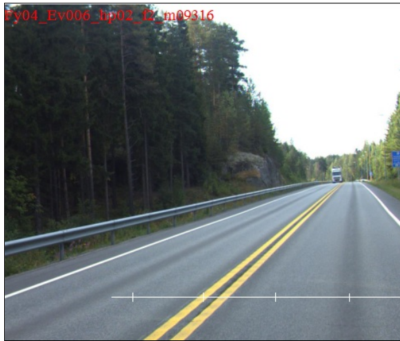
Figur 5 Nedfreste sinusriller på E6 hp 2 m 9316 i Hedmark.
