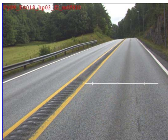
Figur 3 Rumleriller på E18 hp 3 m 5810 i Aust-Agder. Figur 4 Sinusriller på rv. 3 hp 1 m 2155 i Hedmark.
