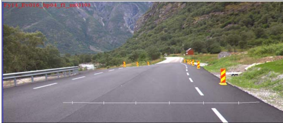
Bilde nr. 18: standardsprang på rettstrekning der det har vært en dødsulykke
