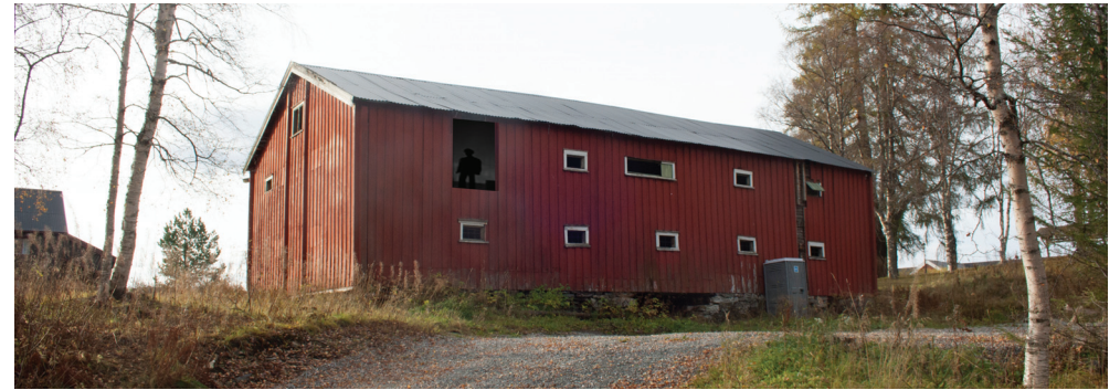
Vindu bare i 2. etg med panelet trukket til side.
