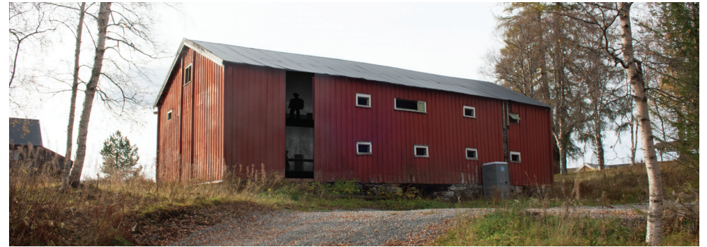
Vindu fra topp til bunn med panelet trukket til side.
