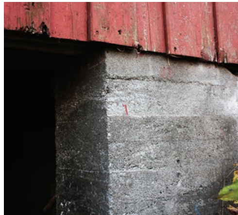
Reparasjon med betong
