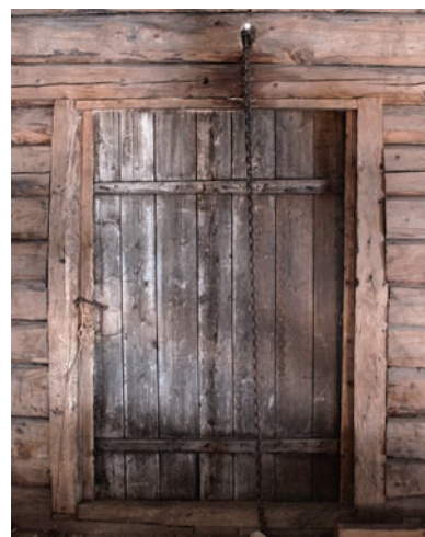
Port i 3. med kjettingen over.
