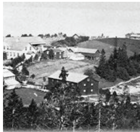
Her ser man vinduene på østfasaden i original stand. 6
