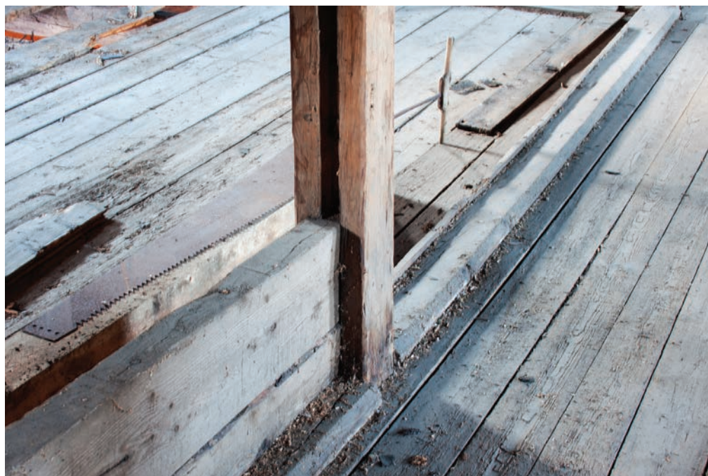
Sleppverksvegg i 2. etasje
