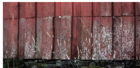
Utskifting av panel
