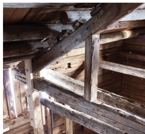
Provisorisk understøtting av sperrebukk
