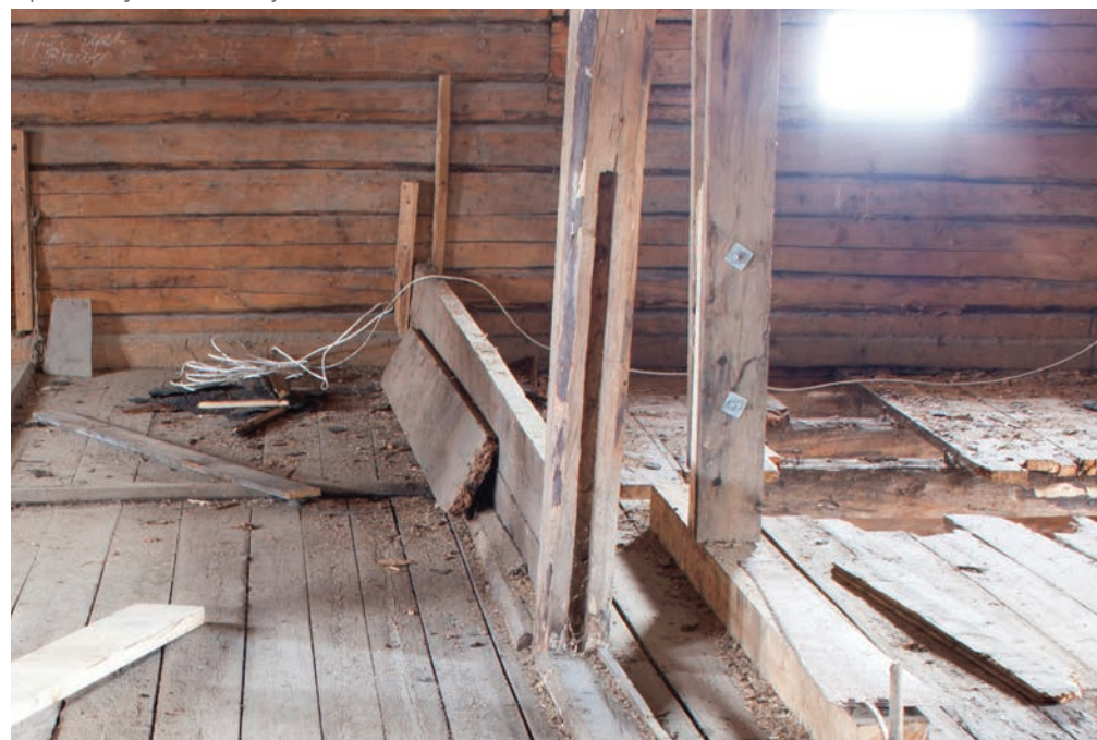
Sleppverksvegg i 2. etasje
