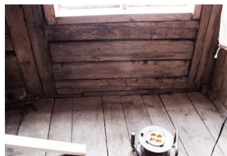
Spor etter dør i 1. etasje.
