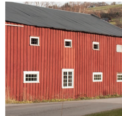
På sørveggen ser man det store vinduet der man tidligere har hatt en dør/port.
