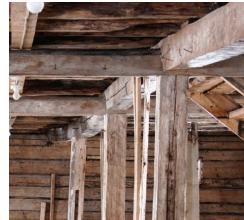
Nedbøyning drager 2. etasje. østre del
