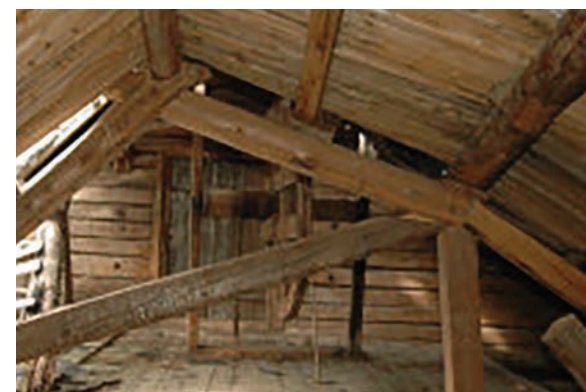
Heishjulet før det ble montert ned.
