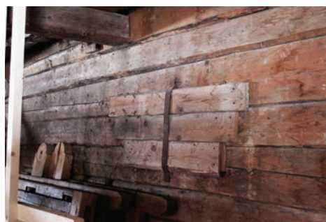
Vindu tettet i 1. etasje.
