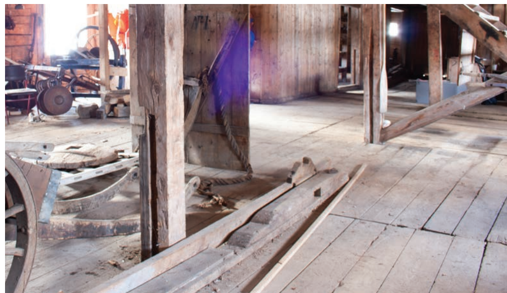
Spor i søyler i 1. etasje
