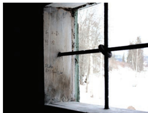
Skrift i vinduskarm i 1. etg.
