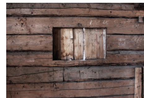
Vindu i 2. etasje tettet med panel
