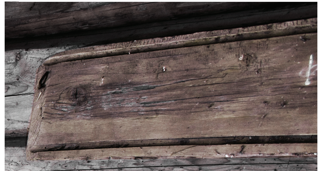
Mulig original taktekking, underbord
