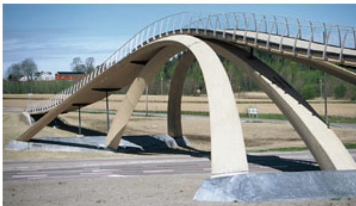
Figur 1: Limtrebjelker med spesiell geometri, dimensjoner og lange spenn i bruk i Da Vinci-broen på Ås [5]
