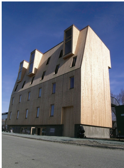
Figur 2: Norges høyeste trehus, boligblokk i Trondheim
