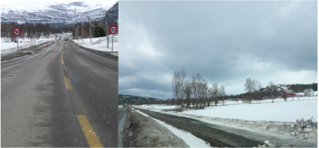
Figur 6.37: Til venstre sees strekning 4 sett fra km. 3300 og i retning økende kilometrering. Rett bak 50 skiltet på venstre side av veg ble oppgravingen utført. Bildet til høyre viser en oversikt over det topografiske landskapet øst for vegbanen.
