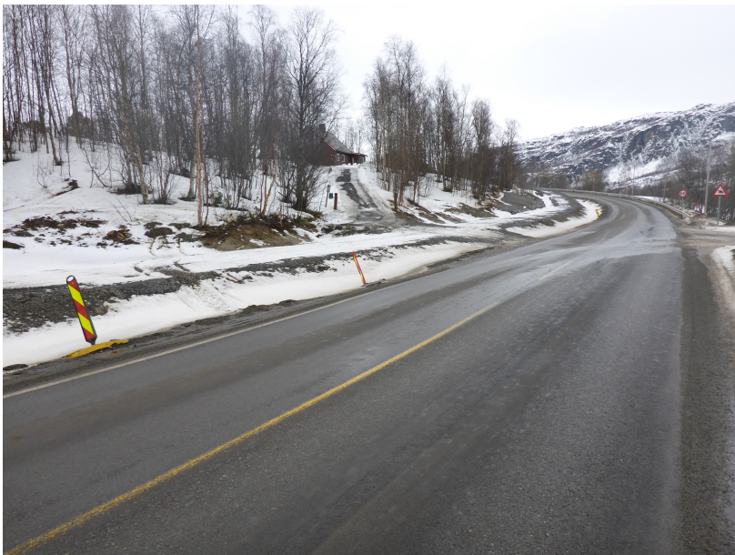
Figur 6.34: Oversikt over strekning 3. Bildet er tatt fra startpunkt for GPS-målingene og ser i retning av økende kilometrerung
