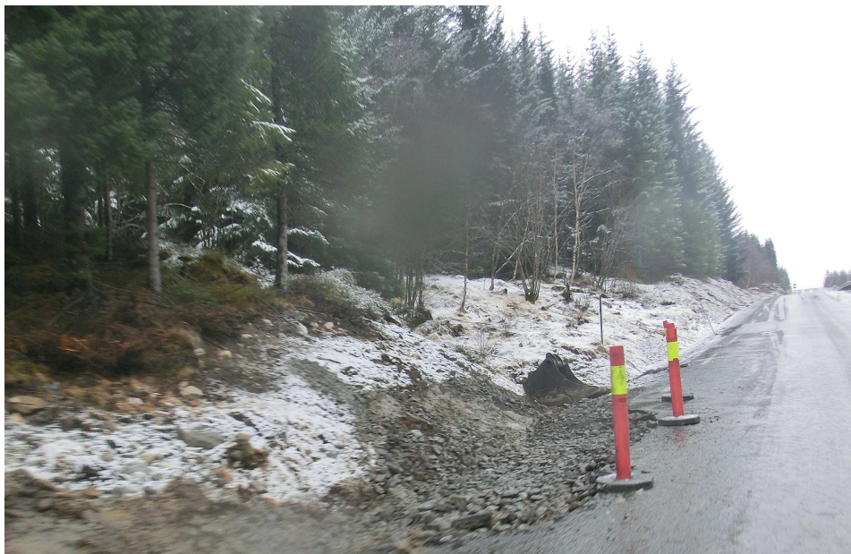
Figur 6.8: Tilbakelagte masser etter endt oppgraving.
