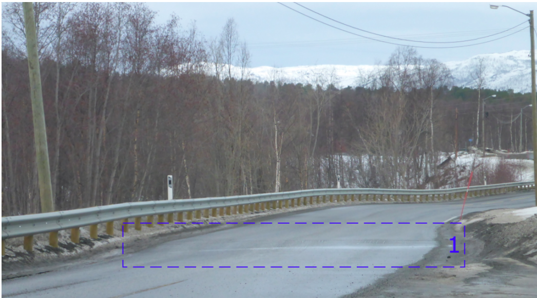
Figur 6.29: Ujevnhet på veg ved avslutning av skumglass-fylling (km. 2105).
