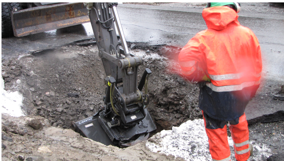
Figur 6.4: Utgraving av masser.
