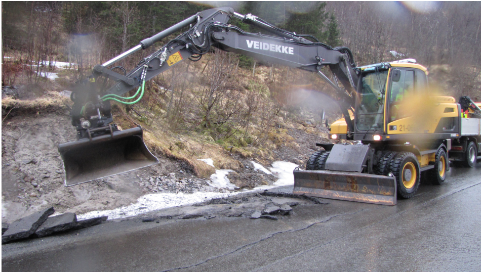
Figur 6.3: Oppbrekking av asfalt før oppgraving.
