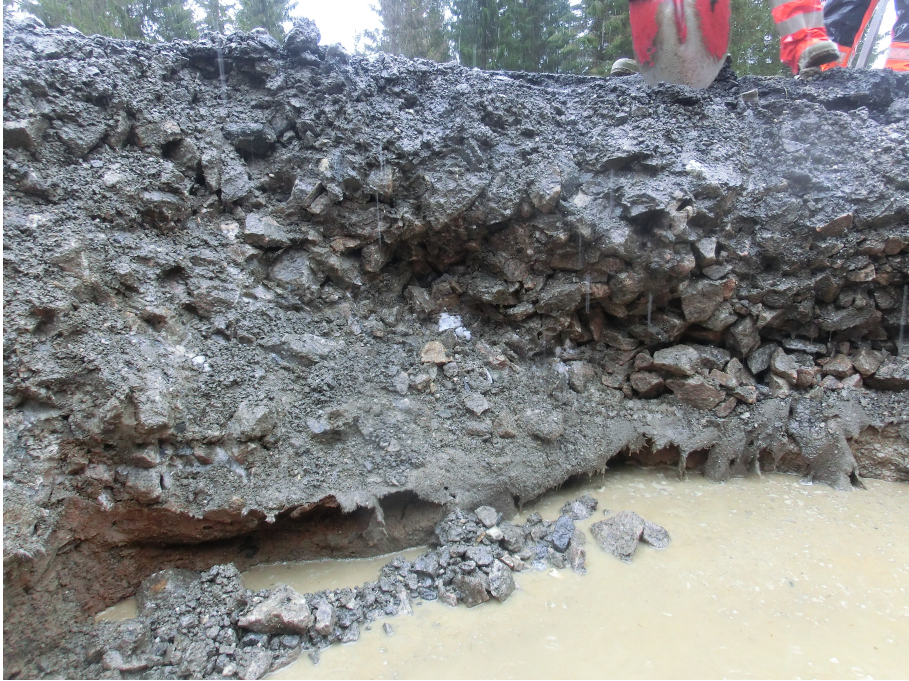
Figur 6.13: Tverrsnitt av profil 1 Meløy. Det er tydelig forskjell i finstoffordelingen til pukklaget.
