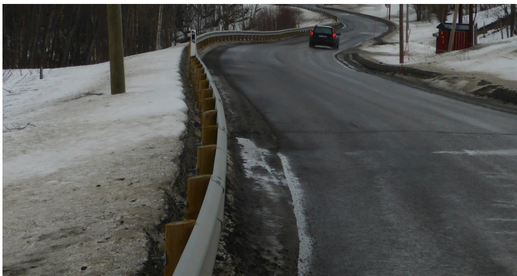
Figur 6.30: Avslutning av skumglass-fylling (km. 2105) avbildet fra høyre side av veg.
