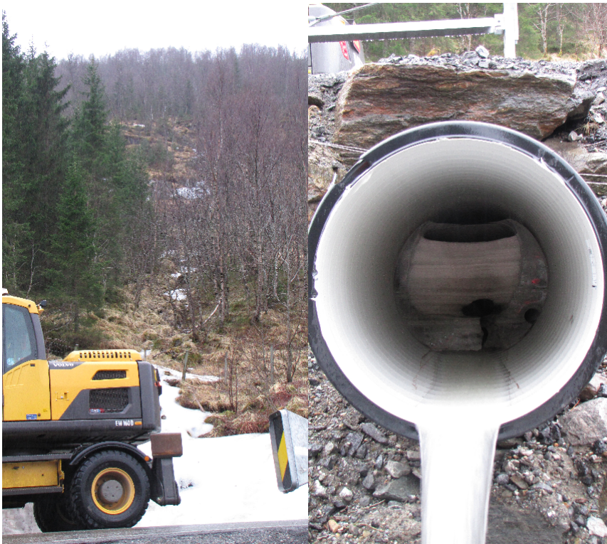
Figur 6.12: Til venstre vises skråning i bakgrunn av profil Meløy 1. Til høyres vises stikkrenne like ved profil Meløy 1.
