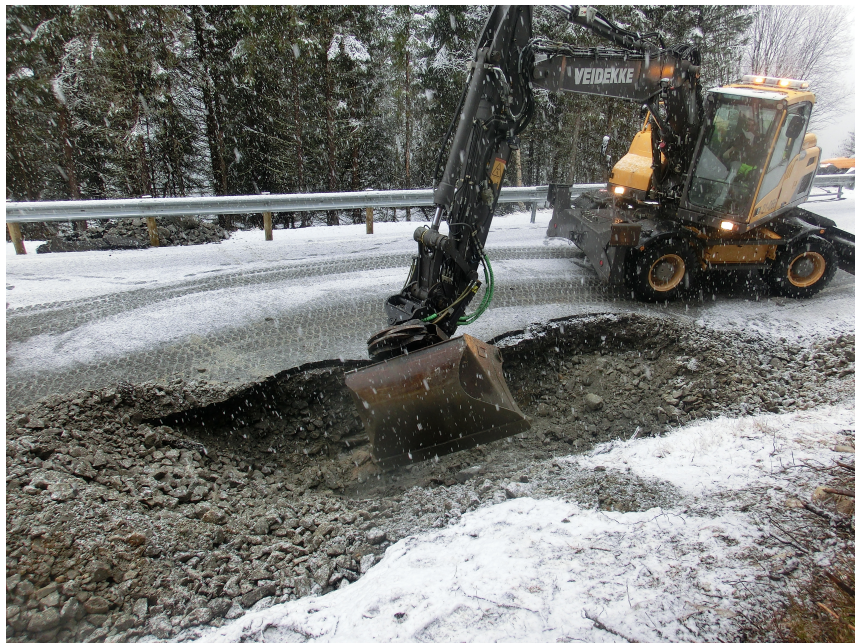
Figur 6.16: Ved oppgraving var undergrunnen overraskende tørr, og i søken etter islinser ble det gravd i bredden.
