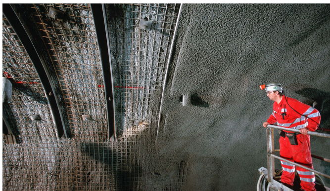
Figur 5.5: Bruk av stålnett og stålbuer i Gotthard base tunnelen (TunnelTalk, 2008)
