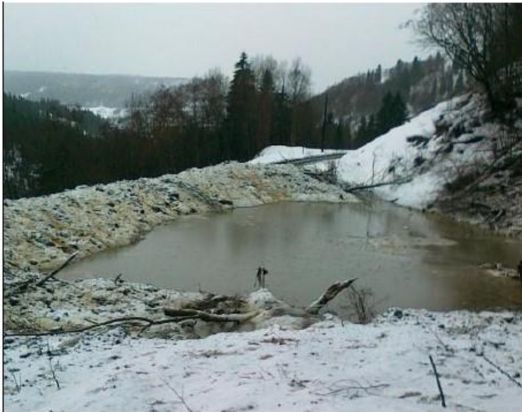
Figur 10.12: Bildet viser oppdemming av vann bak jernbanefyllingen etter skredet 13. mars (Jernbaneverket, 2012).
