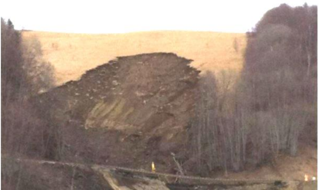
Figur 10.1: Jordskredet 13. mars 2012, utløst på et jorde 150-200 m ovenfor jernbanesporet (Jernbaneverket, 2012).
