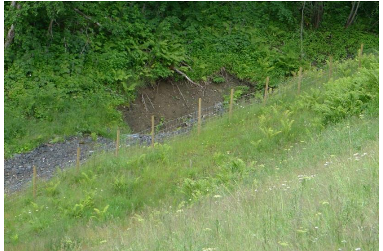
Figur 11.4: Området blottlagt med løst pakket jord ved innløp til stikkrenne (Foto: Terje H. Bargel).
