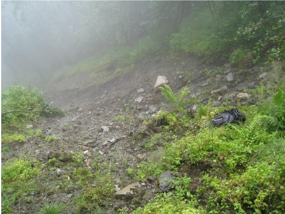
Figur 5.44 Utløsningsområde 2 befant seg ca. 30 meter nedenfor utløsningsområde 1, der det hovedsakelig ble observert spor etter rennende vann mellom lokalitetene. Løsmassene kan man på bildet se varierte fra finkornet til større blokker. Se sekk som målestokk. Foto: Daniel Haugen Edvardsen.
