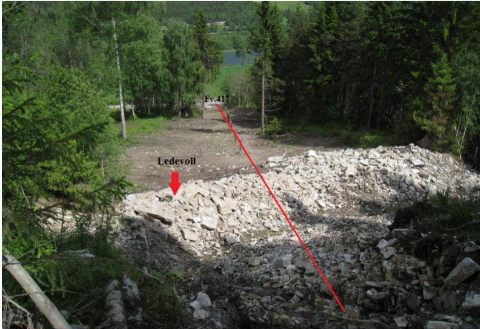
Figur 5.8 Utløpsområdet til skred 1. Rød strek markerer hvor skredet beveget seg nedover og over fylkesvei 417. Bredden på skredpartiet er ca. 30 meter. I etterkant har det blitt bygget en ledevoll som skal forhindre mer massetransport over veien (markert med rød pil). Foto: Daniel Haugen Edvardsen.
