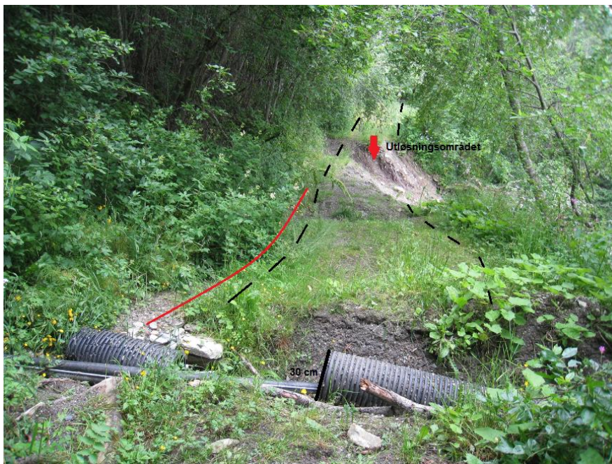
Figur 5.12 Utløsningsområdet til skred 2 markert med rød pil. Beliggenheten til utløsningsområdet befant seg langs den ytre skulderen til skogsbilveien, markert med svart stiplede linje. Utløsningsområdet lå lavest langs skogsbilveistrekningen. Den ødelagte stikkrenna ble målt til å være 30 cm i diameter (svart strek), og siden utløsningsområdet lå lavere i forhold til beliggenheten til stikkrenna, rant vannet nedover mot dette partiet. Rød linje viser hvor det ble observert spor etter rennende vann i retning ned mot utløpsområdet. Det ble ikke observert noen grøft langs det indre partiet til skogsbilveien, der vannet ideelt sett skulle blitt drenert Foto: Daniel Haugen Edvardsen.
