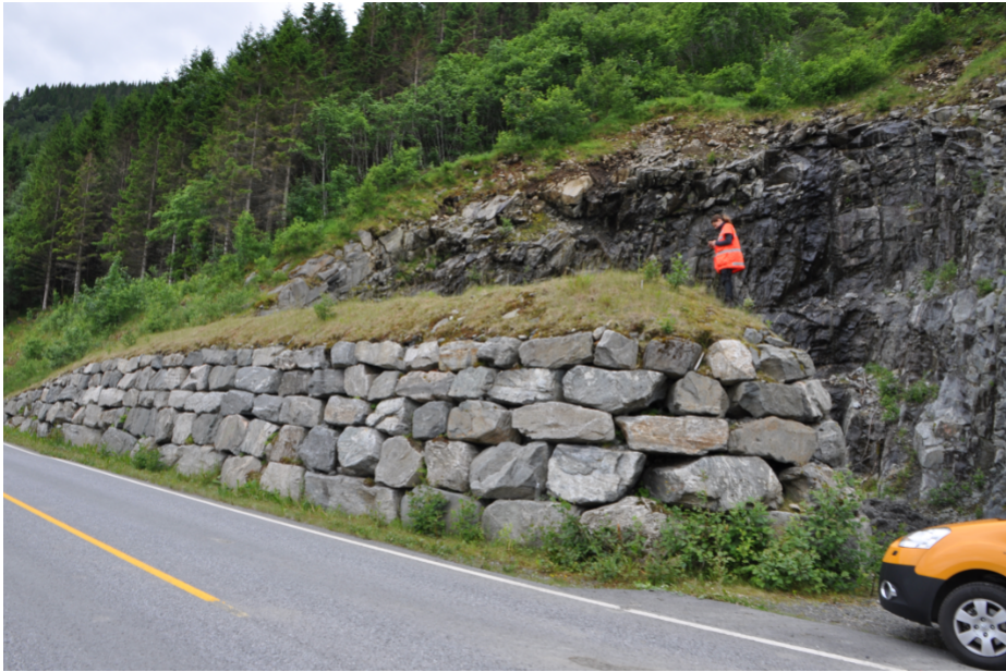
Figur 3.14: Fangvoll og utsprengt magasin ved fv.47 ved Steinnestranda i Møre og Romsdal (Foto: Marie Drågen).
