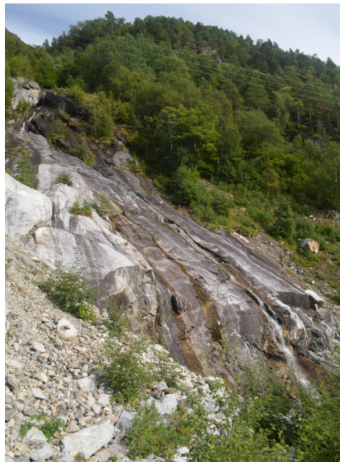
Figur 7.14: Bakre vegg til magasin ved utløp til Djupfonna (Foto: Kari Linn Søreide).
