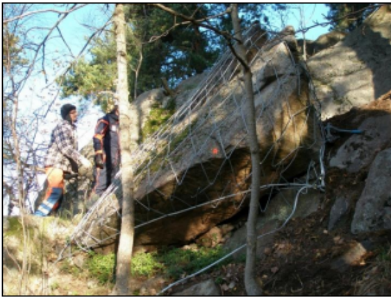
Figur 2.13: Wirenett av typen Geobrugg Spider” (Foto: K. Moen, Multiconsult AS).
