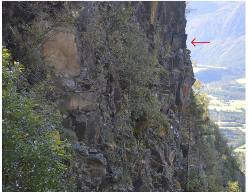
Figur 6.31: Nærbilde av fjellblotningen. Rød pil viser blokk hvor det er fare for utglidning. Det vises små løse blokker langs hele blotningen (Foto: Kari Linn Søreides).
