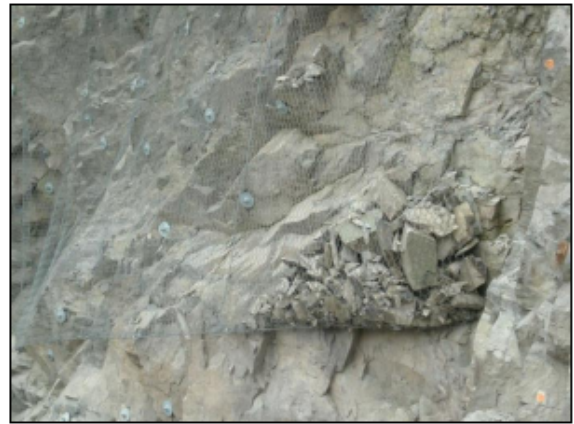
Figur 2.14: Steinsprangnett som viser ut-raste steinmasser (Foto: K. Moen, Multiconsult AS).
