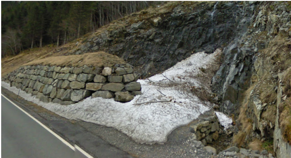
Figur 3.15: Snøskred stoppet av fangvoll ved fv.47 ved Steinnestranda i Møre og Romsdal (hentet fra maps.google.com ).
