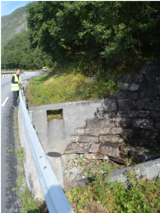
Figur 7.2: Magasin ved utløpet til Driva, sett fra siden.
