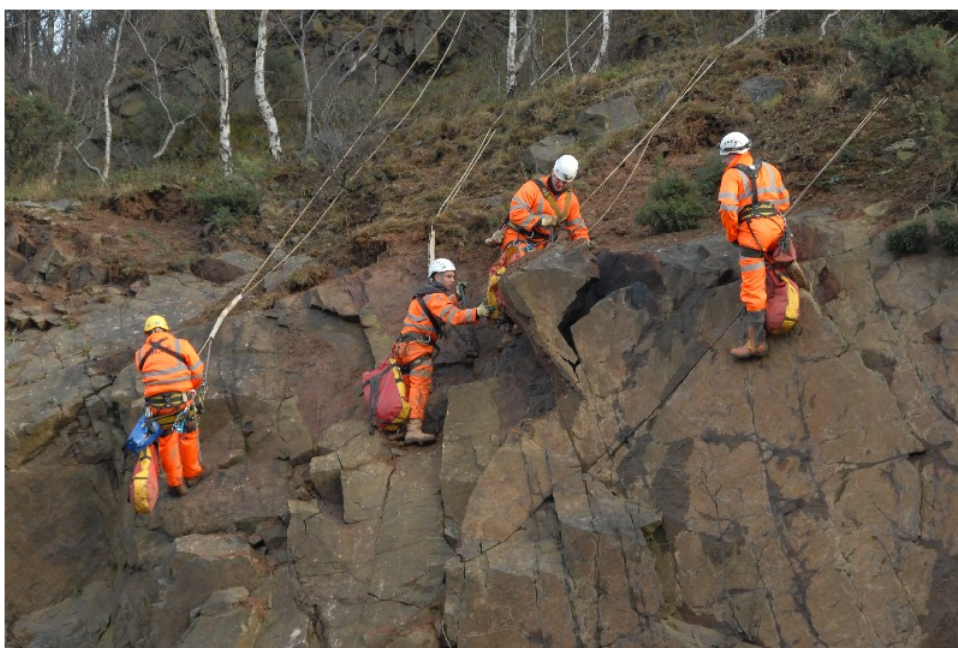
Figur 2.12: Fjerning av løs blokk ved skalering (Foto: K. Moen, Multiconsult AS).
