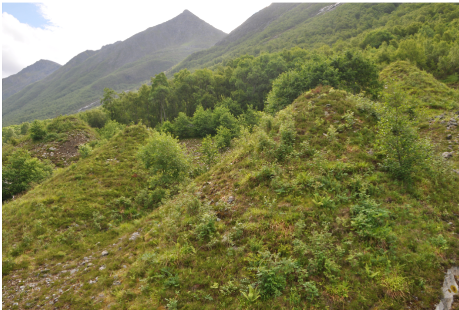
Figur 3.17: Bremsekjegler ved E39 Hvardalstranda i Møre og Romsdal (Foto: Marie Drågen)
