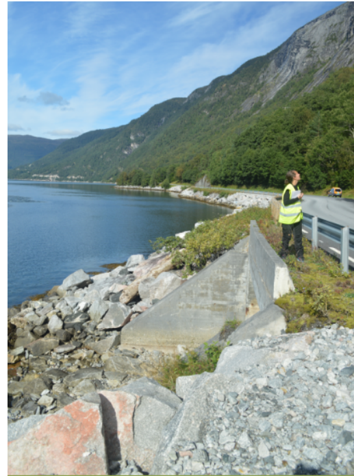
Figur 7.3: Utløp av Driva i betongrenne under vei.
