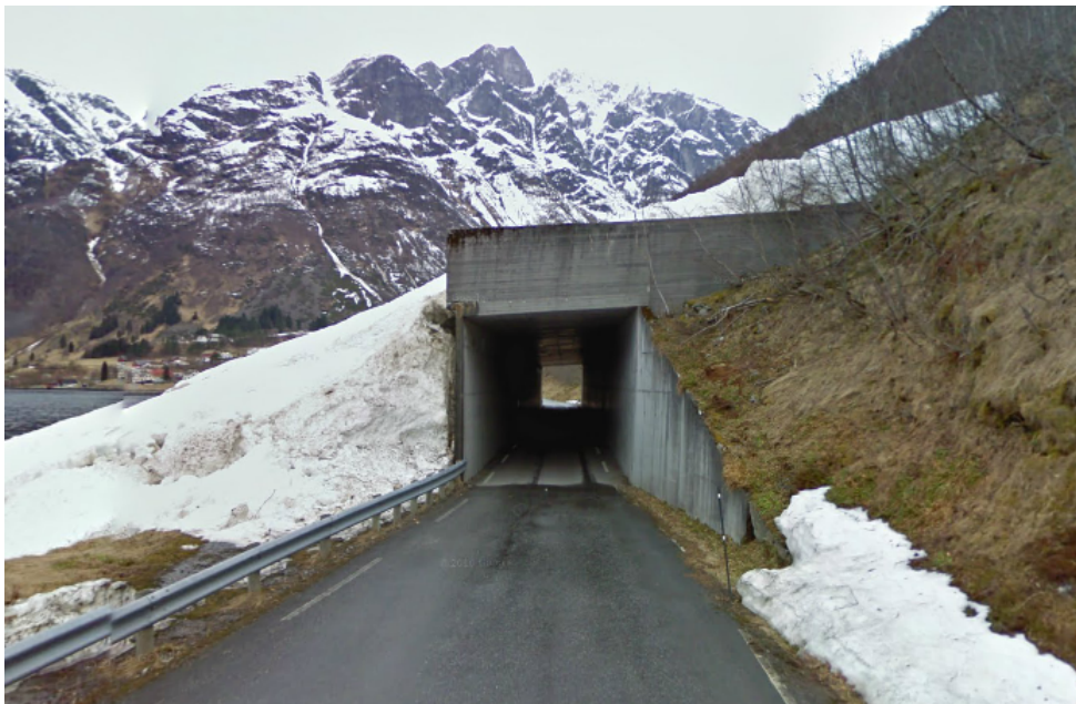
Figur 3.20: Snøskred som har gått over skredoverbygg ved fv.41 Løggjølet i Møre og Romsdal (hentet fra maps.google.com)
