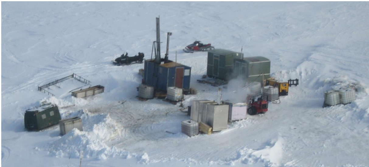
Figur 18: Bildet viser boreplassen, her på Lunckefjell. Boreriggen er plassert inne i den blå brakken, oppholdsrom og lager i de grønne. De 6 m lange borstengene står oppreist ved siden av boretårnet. Dampen fra snøtiningen sees tydelig i forkant av de grønne brakkene. Transporten foregår ved hjelp av snøscooter, tråkkemaskin og helikopter. H. Velve, 2007.
