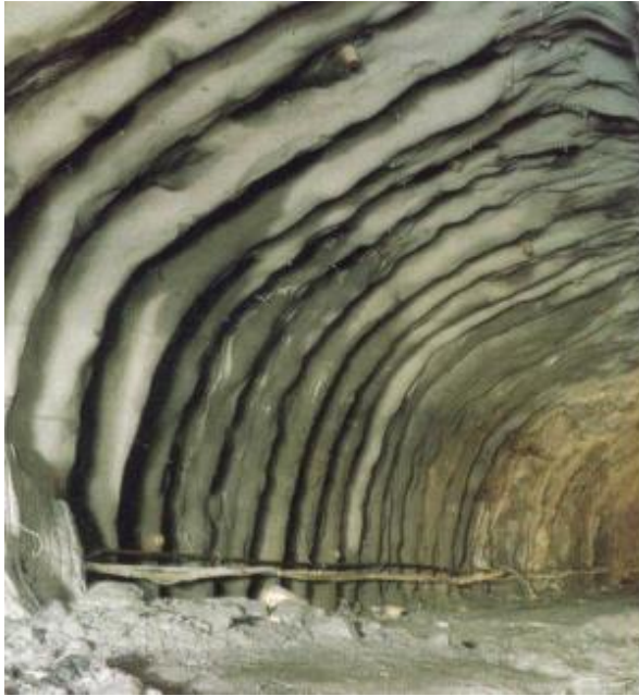
Figur 29 viser til venstre armerte sprøtebetongbuer sett innenfra tunnelen. Til høyre kan man se et snitt av en sprøtebetongbue (Sve, et al., 2008).
