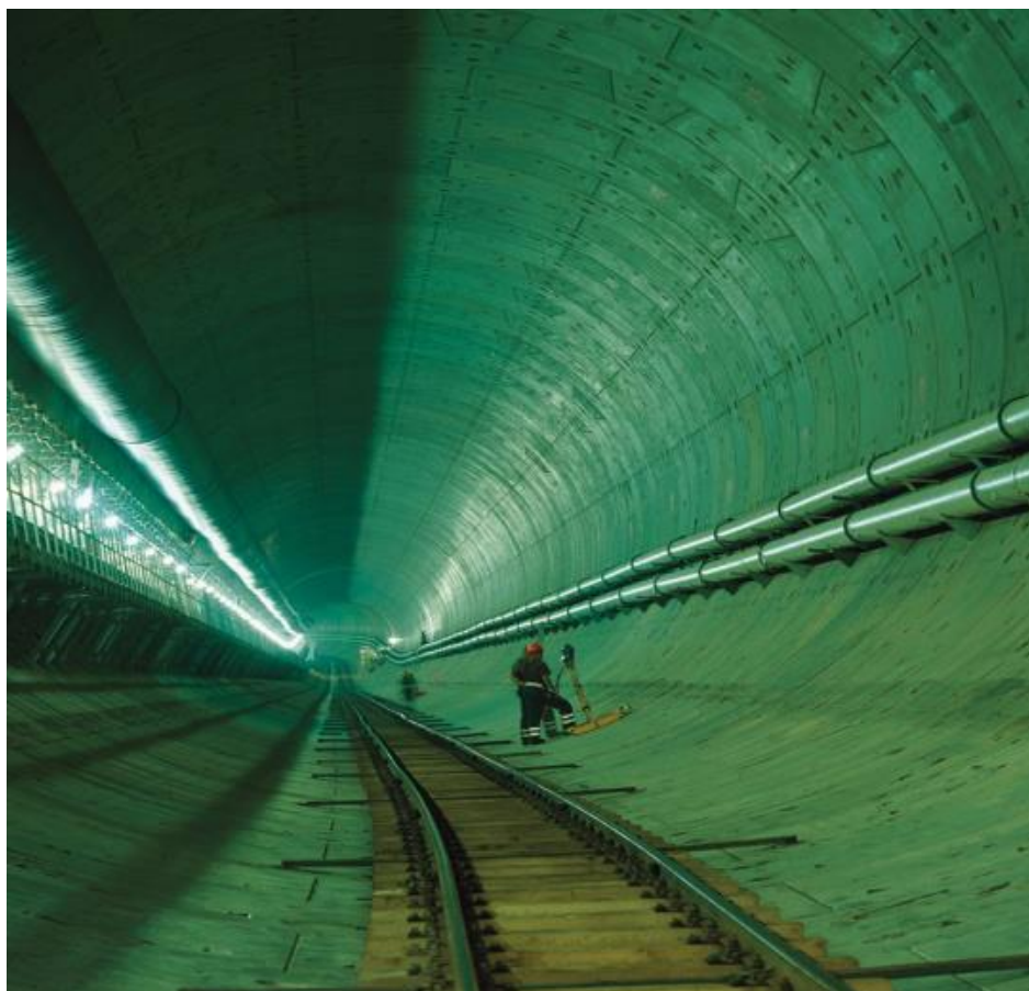
Figur 55: Fullprofilboret tunnel linet med betongsegmenter. Foto: Herrenknecht AG.
