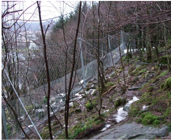
Bilete 4 – Fanggjerd, sikringstiltaket over tomta.
