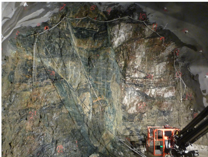
Figur 5.18 – L11, profil 7828. Leirholdig sone i senter av stuffen. Bildet er tatt mens det utføres injeksjonsarbeid. Foto: Mari Lie Arntsen.
