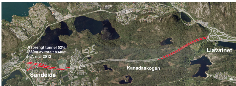
Figur 5.3 – Oversiktsbilde av tunneltraseen med de drevne strekninger per 7. mai markert i rødt (Statens vegvesen, 2012b).
