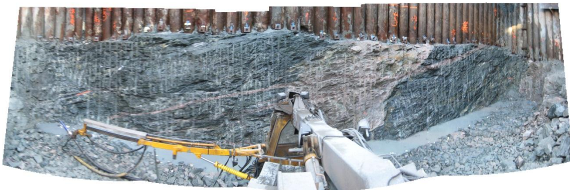
Figur 6-2. Panoramafoto av tunnelpåhugget. For større bilde, se Vedlegg 6. Foto: Svein Hove
