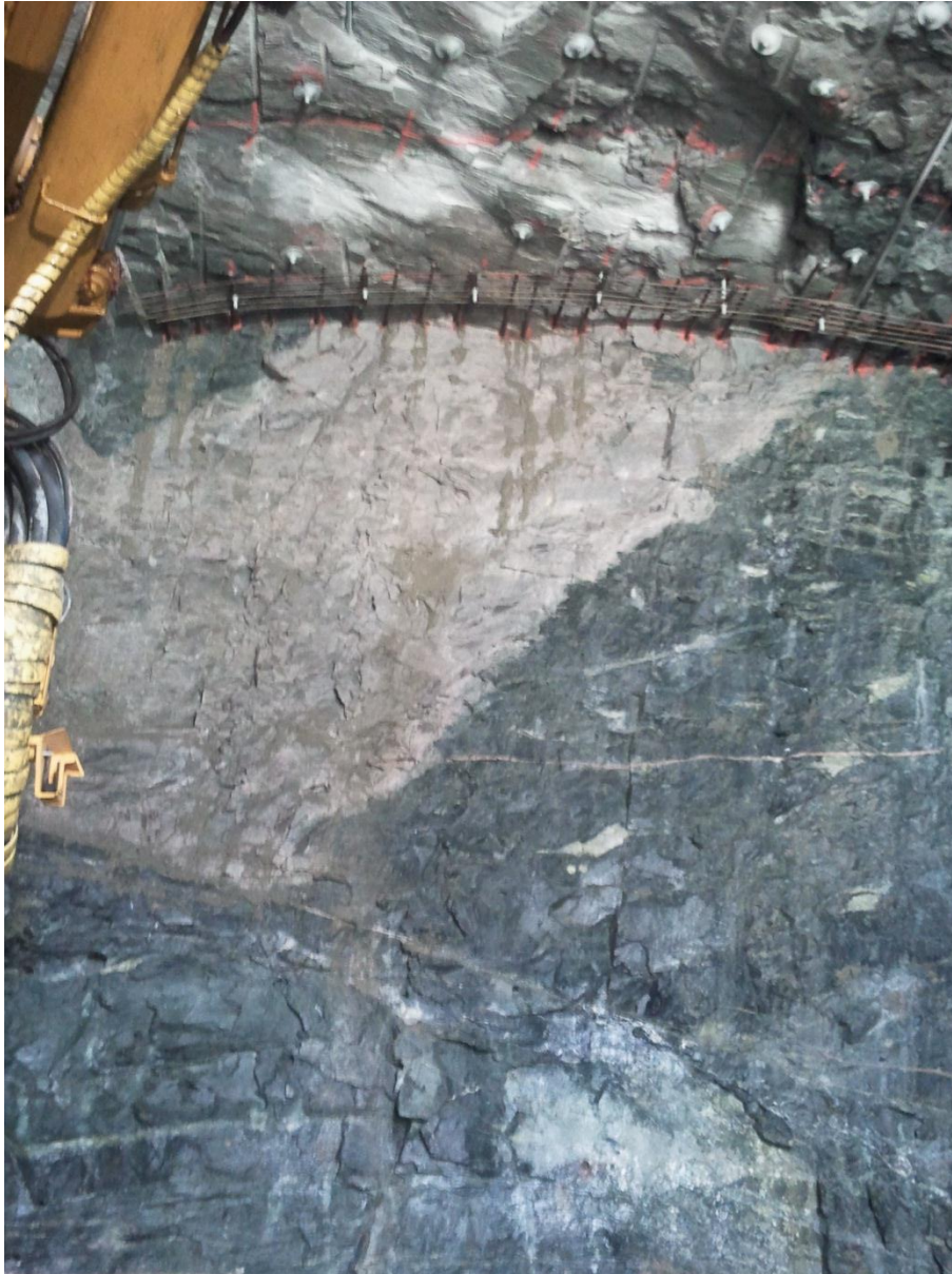
Figur 5-3. Ikke-konkordant overgang mellom grønnsteinen og den intrusive trondhjemitten. Foto: Asta Krattebøl
