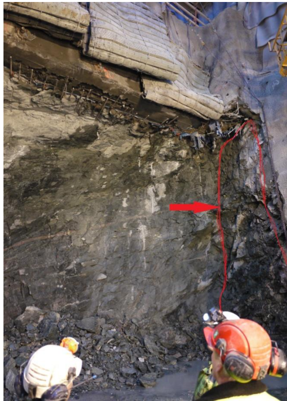
Figur 31: Sidevegg av påhugget etter de første salvene
