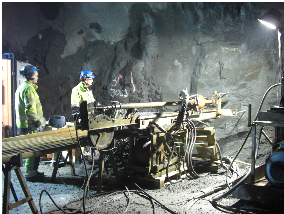
Figur 6-4: Borplass for spenningsmålinger (Foto: E. Stormyr, 2012).
