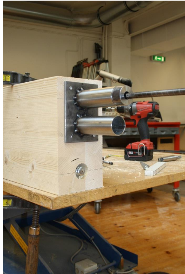
Figur VI-18: Boret så med 15mm boret 700mm inn i bjelken fra ytterkant.
