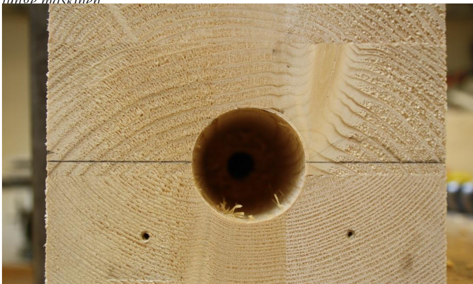
Figur VI-19: Bildet viser hvordan hullet for gjengestaget er sentrert i hullet for hylsen. Gjennom alle hullene som ble boret ble det ikke registrert noen hull som ikke var sentrert i hylsehullet.
