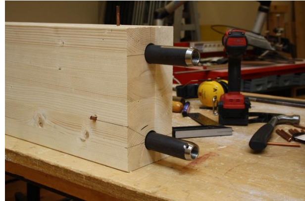
Figur VI-24: Her visen en bjelkeende som er klar til skjøting. Hylsene er montert inn i hullet rundt gjengestaget og blir holt fast av gyserørene i siden.
