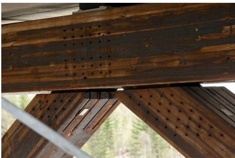
Figur 2-2: Forbindelse med innslissede stålplater og dybler.
