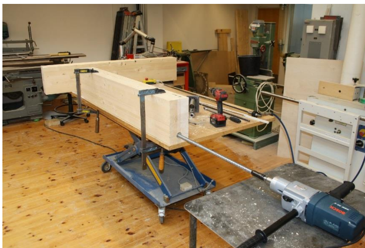
Figur 5-7: Bildet viser inngjenging av gjengestag i hullet som er forboret
