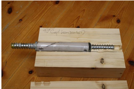
Figur V2-7: Noe lekkasje fra enden av hullet. Lim som har kommet mellom hylse og hull i treverket. Ikke pga lekkasje mellom pakning og skrue.
