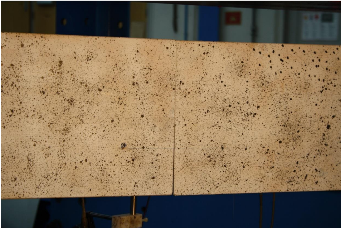
Figur V4-41: Sprekk i skjøten ved ca. 20mm nedbøyning av bjelken.
