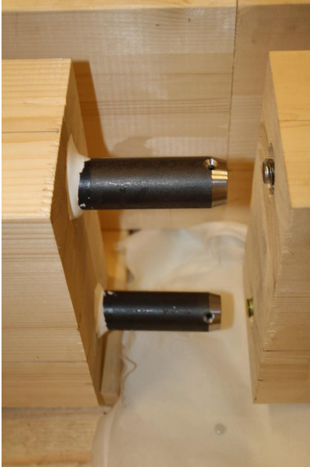
Figur VI-27: Det ble benyttet silikon for å tette opprommet mellom hullet i treet og hylsene. Dette sikret oss mot lekkasjer mellom bjelkeendene ved gysing.
