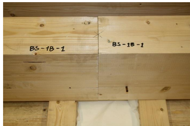
Figur VI-25: Bjelkeskjøtet ved montering.
