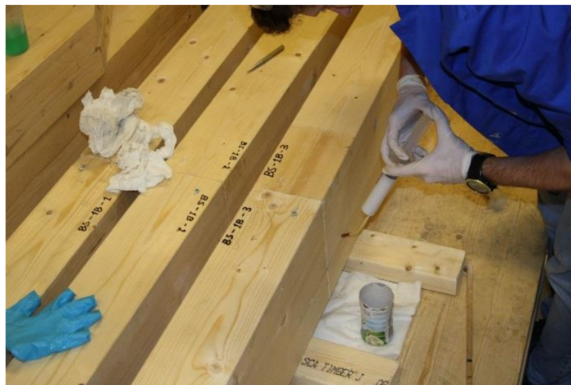
Figur 5-9: Gysing av lim etter at bjelkene var ført sammen.
