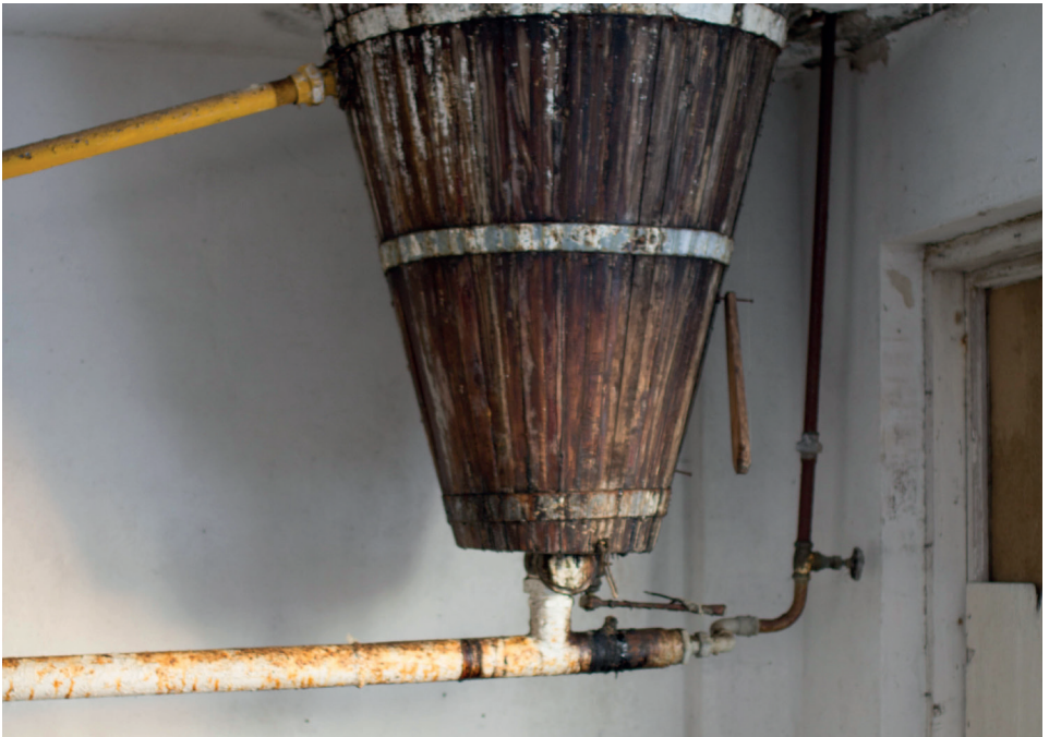
Trantønne sett fra andre etasje.
