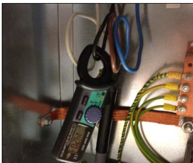
Figur V4-4 Straummåling med tangampermeter på IK42.
