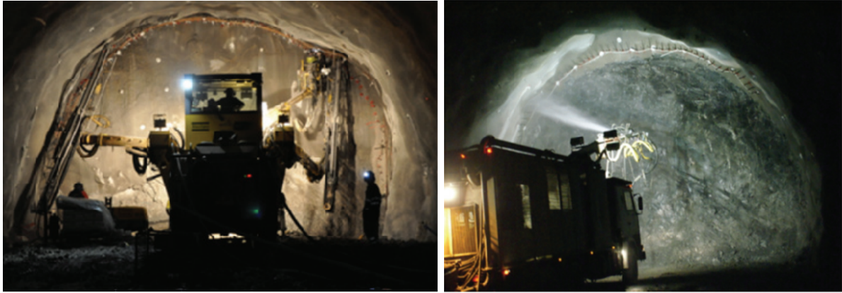
Figur 6-3: Montering av sprøytebetongbuer; installasjon (venstre) og sprøyting av buene (høyre) (Moen, 2011b).
