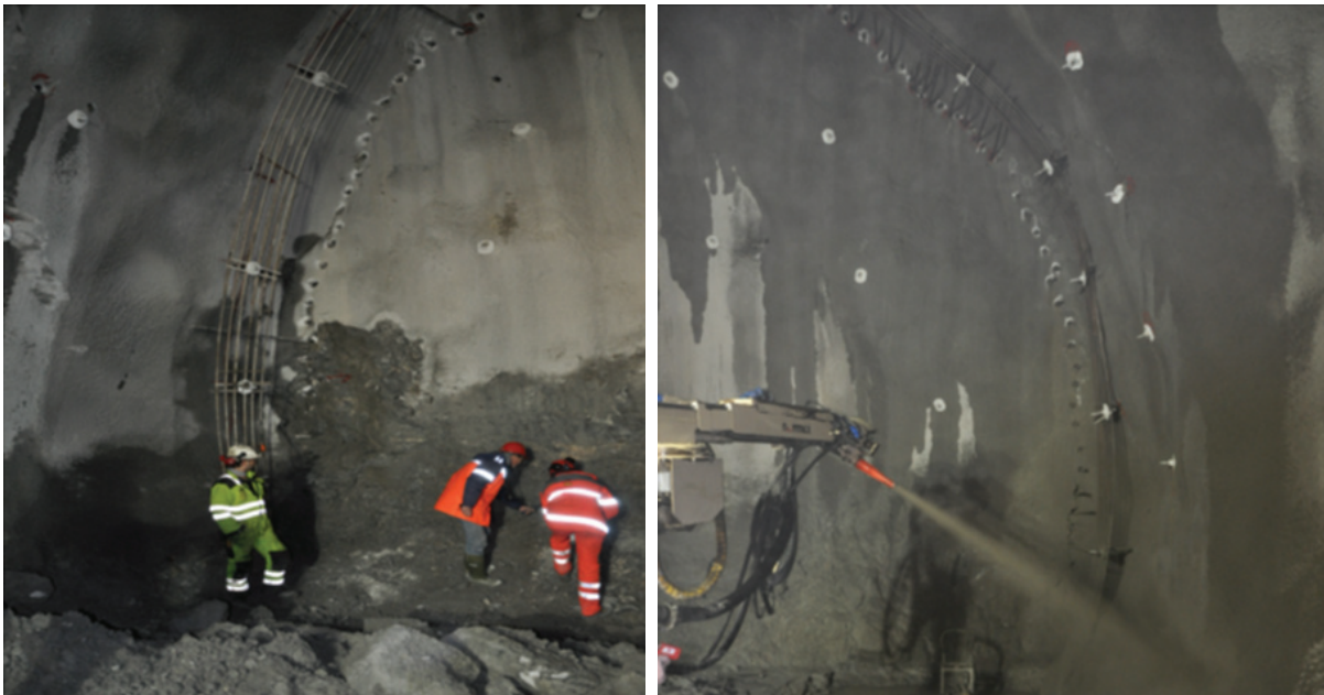
Figur 6-4: Forbolting og installasjon av armerte sprøytebetongbuer på stoff
