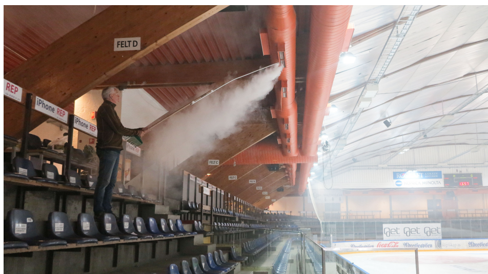
FIGUR 8.3: Røyk tilsatt til utblåset som går skrått nedover. Luften treffer kun den øverste raden. I tillegg ser det ut som den treffer med relativt høy hastighet, noe som er lite gunstig med tanke på den termiske komforten.
