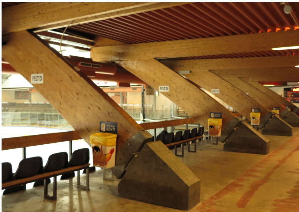
FIGUR 4.11: Her vises de buede bjelkene og metallplatene i taket
