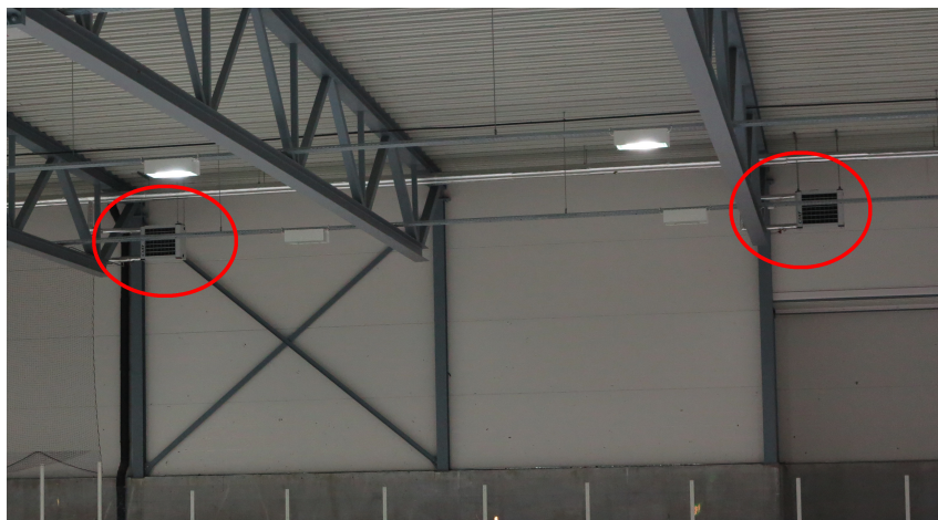
FIGUR 4.20: Oppvarmingsmetode for treningshallen. Foto: Daniel Bergsagel
