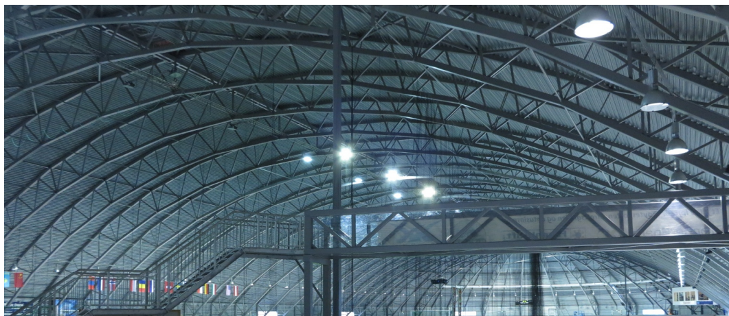
FIGUR 4.3: Illustrasjonsbilde av konstruksjonen. Foto: Daniel Bergsagel
