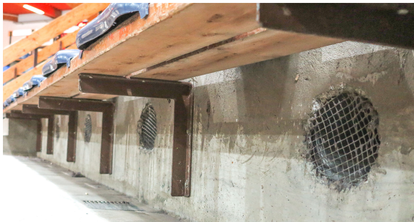
FIGUR 4.15: Luften som tilføres under taket suges ut gjennom kanaler under stolene på tribunen
