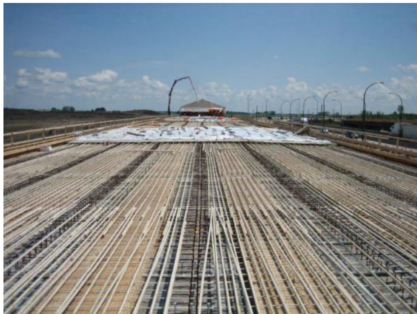
Bilde 2: Stangarmering av GFRP, Floodway Bridge i Manitoba, Canada (Busel 2012).
