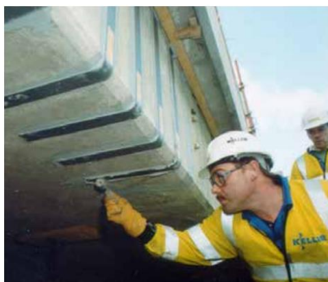
Bilde 7: Bruk av CFRP til skjærforsterkning av bjelke (Sika 2014a).
