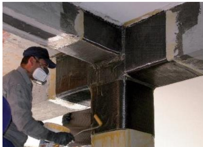
Bilde 11: CFRP-forsterkning av bjelke-søyleforbindelse.
