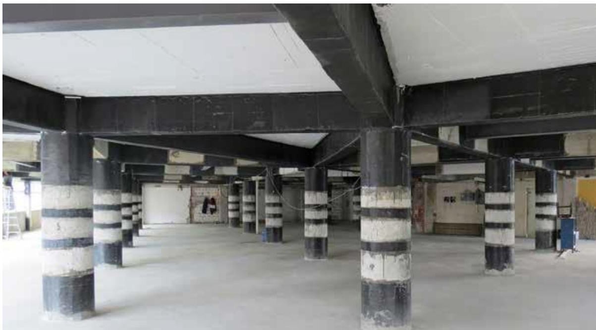
Bilde 10: Søyler forsterket med SikaWrap, CFRP (Sika 2014b).
