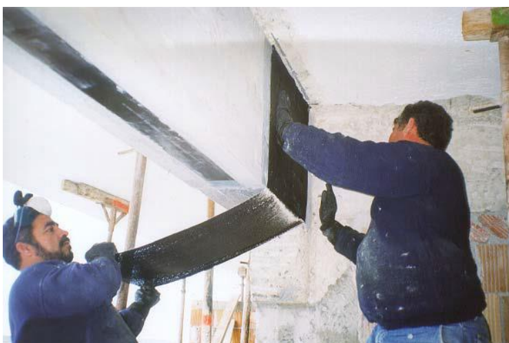
Bilde 8: Skjærforsterkning av betongbjelke med CFRP (FIB 2001).
