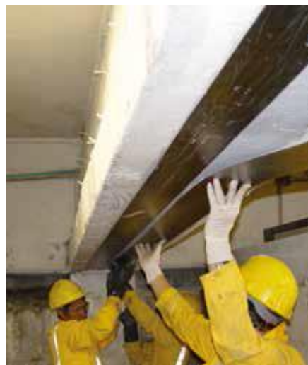
Bilde 6: Bruk av CFRP til momentforsterkning av bjelke (Sika 2014a).
