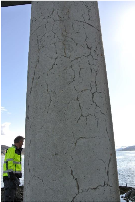
Figur 25 Krakelering nordrepilar akse 3 mot nord
