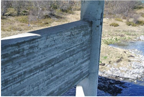
Figur 21 Krakelering akse 4, mot øst
