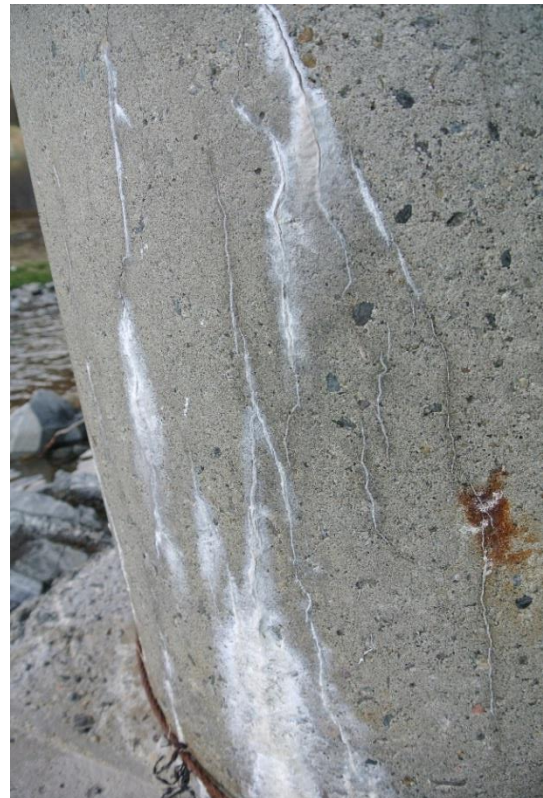
Figur 28 Utfellingene ned på akse 3 søndrepilar mot sør
