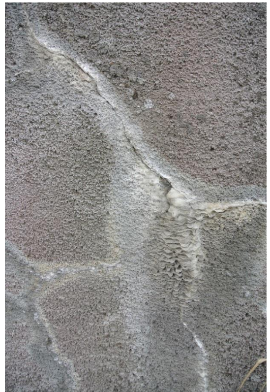
Figur 39 Utfellinger i kabelforankring i øst, mot nord
