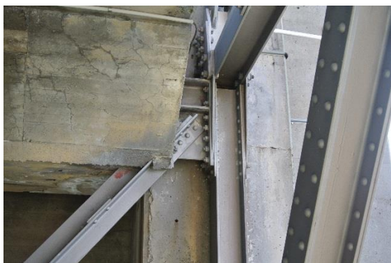
Figur 3 Feste av overgurt inn mot tårn akse 24
