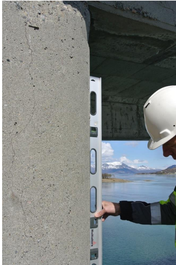
4.10 Mulig deformasjon i pilar
