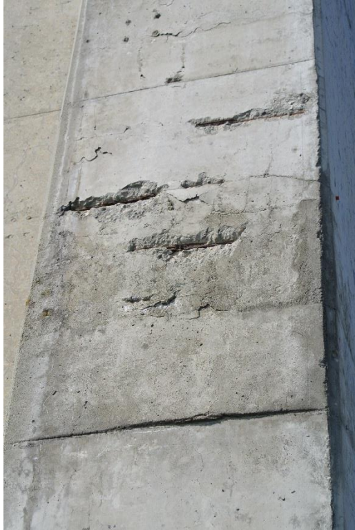
4.2 Frilagt armering ca. 3 meter over kjørebane
