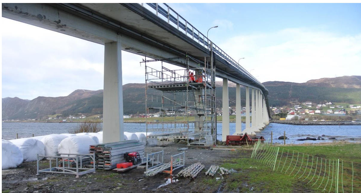
Figur 111: Stillas mellom Akse 2 og 3 for inspeksjon av brubjelken
