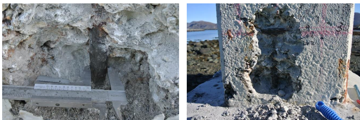
Figur 107: Steinreir på sørsiden av søylen i Akse 5
