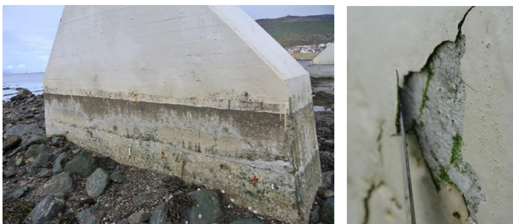
Figur 109: Venstre side av fundament i Akse 6
