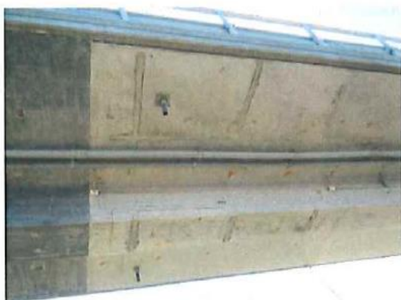
Figur 81: Avflakende belegg over båndanoder i Akse 20 til 21 [12]
