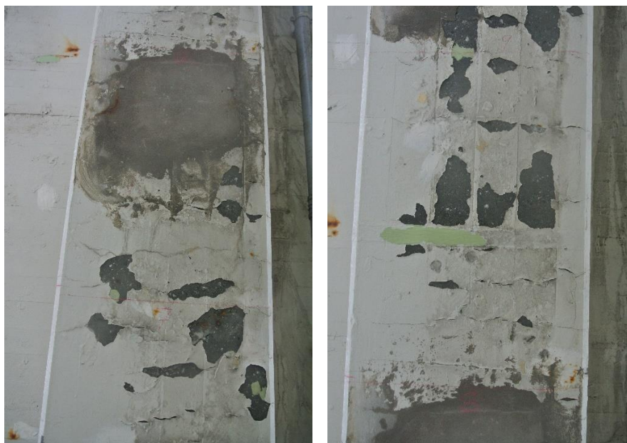
Figur 112: Undersiden av bjelken fra 7 til 9 m fra Akse 3
