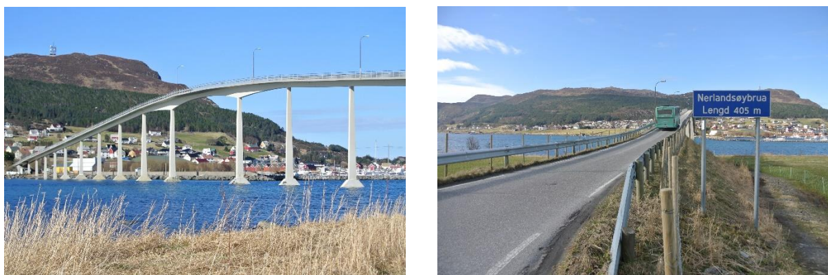
Figur 1: Nerlandsøybrua i Herøy kommune våren 2015
