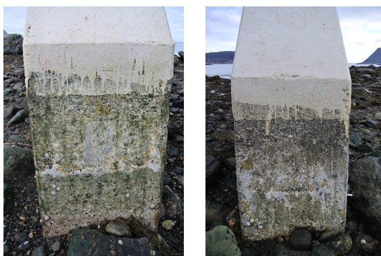
Figur 110: Nordside (venstre) og sørside (høyre) av fundament i Akse 6
