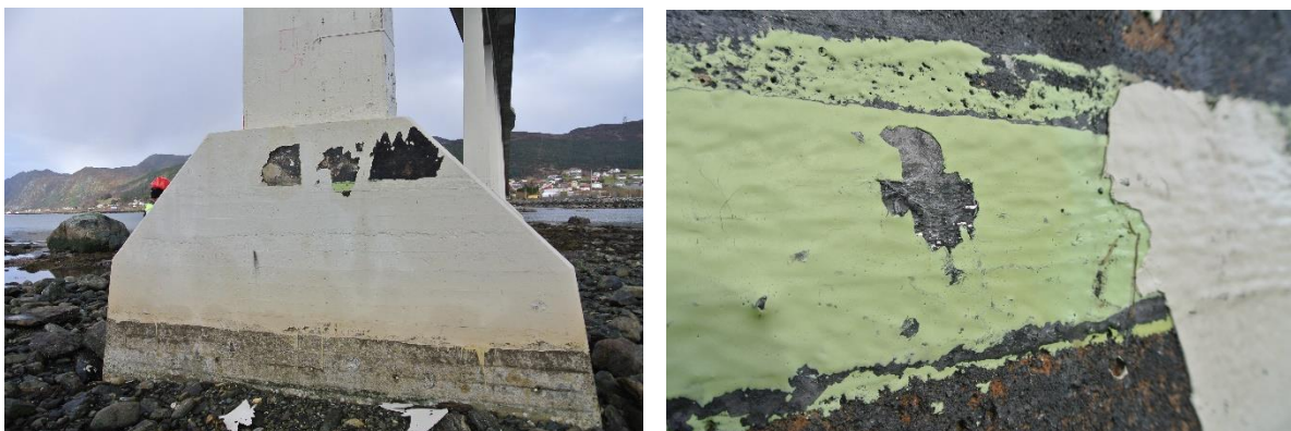
Figur 106: Venstre side av søyle og fundament i Akse 4
