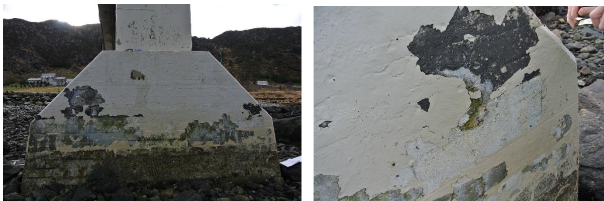
Figur 105: Høyre side av søyle og fundament i Akse 5
