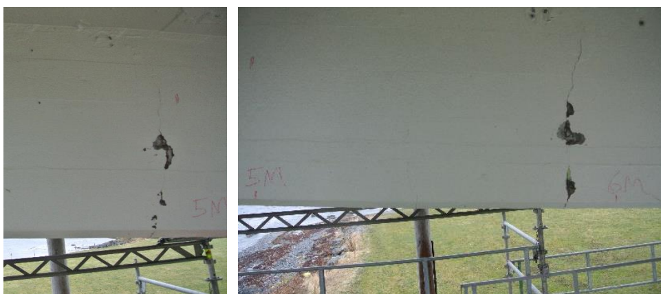
Figur 115: 5 til 6 m på sørsiden av bjelken mellom Akse 2 og 3
