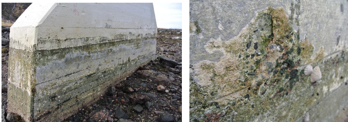
Figur 108: Høyre side av fundament i Akse 6
