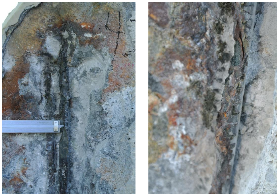
Figur 103: Skadet armering
