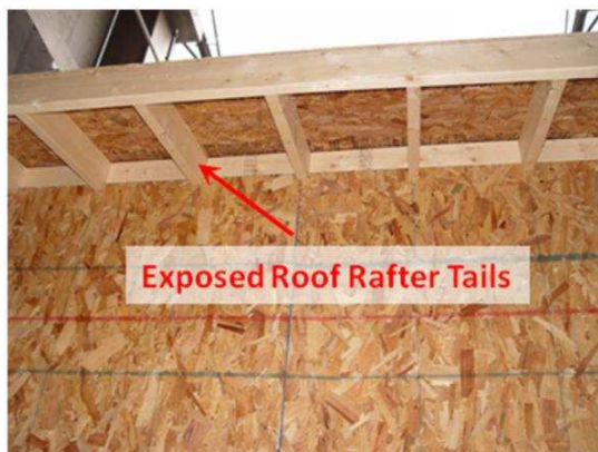
Figur 17: Åpen takfot med og uten ventilering [28]
