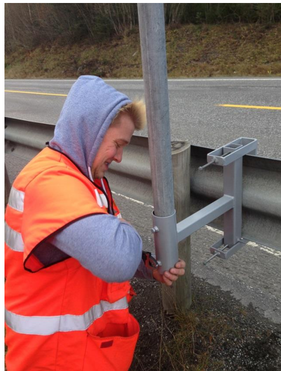
Figur 12, Montering av 449-radar til rekkverksskinne (foto E.Opstad)
