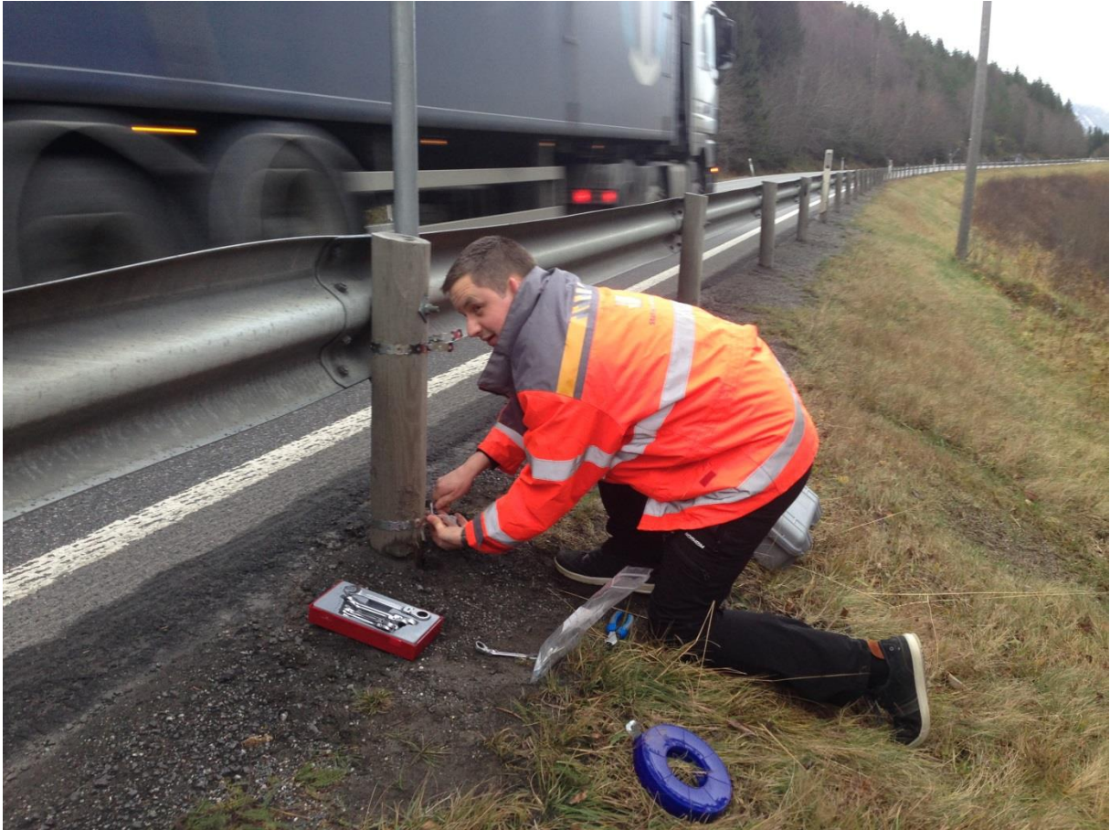
Figur 16, Montering av topo-radar til rekkverksstolpe (foto: Ø. Skare)
